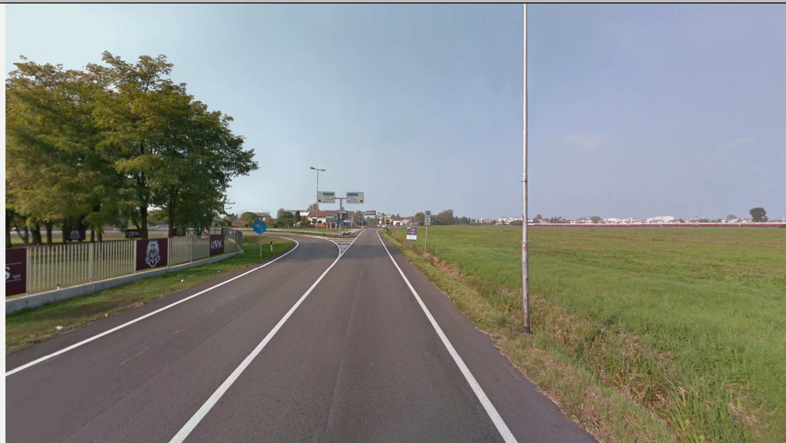
Vista da Via Camisano
