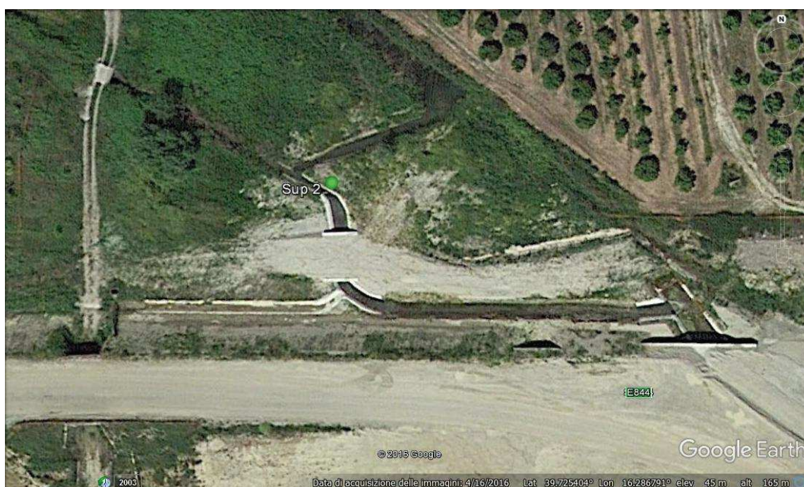
Fig. 03: Scolo irriguo – Stazione di monte A.sup_02
