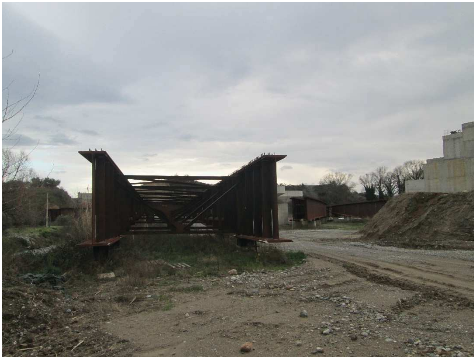
Vista 2 - Impalcato in ferro del nuovo Viadotto Coscile. Sulla destra si osserva la spalla lato Firmo della Carreggiata in direzione Firmo, mentre sulla sinistra è visibile il Fiume Coscile con vegetazione spontanea lungo la sponda.
