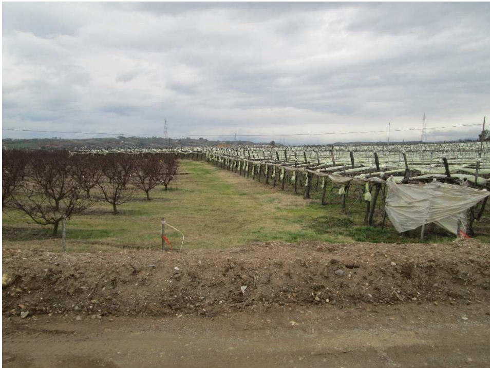
Vista 2 - Frutteti adiacenti all'area di cantiere presso la Rampa D dello svincolo SV02. La pavimentazione stradale è stata rimossa, per le successive operazioni di rettifica planimetrica dell'asse stradale
