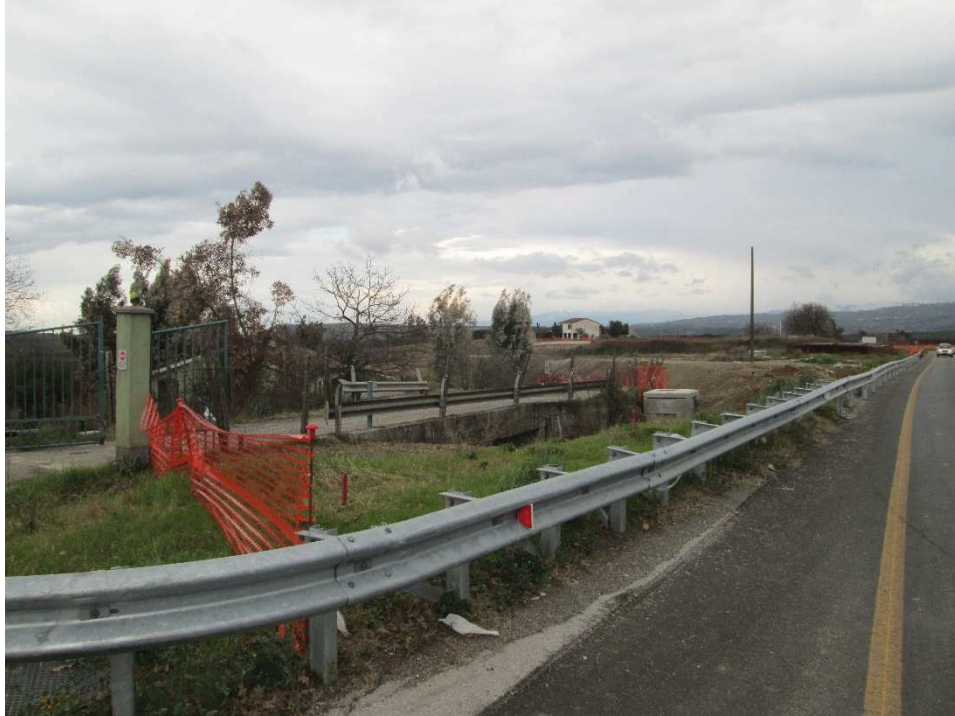
Vista 1 – Rifacimento provvisorio del manto stradale della ex SS19, con installazione dei guardrail
