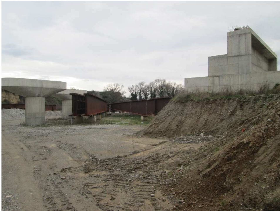
Vista 1 – Impalcato in ferro del nuovo Viadotto Coscile. Sulla destra si osserva la spalla lato Firmo della Carreggiata in direzione Sibari, mentre sulla sinistra sono presenti le pile.
