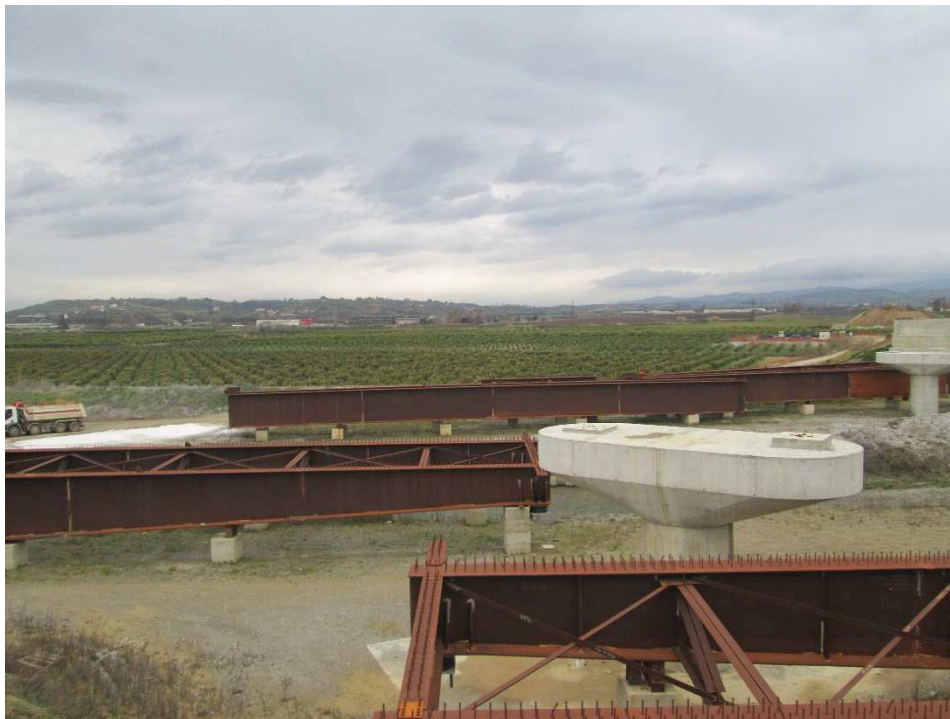
Vista 5 - Punto panoramico della zona sul Fiume Coscile. In primo piano si osserva l'area golenale sulla sponda sinistra del fiume, con le diverse porzioni di impalcato del viadotto, le pile e le spalle sulla sponda destra del fiume. Sullo sfondo si intravedono le porzioni di territorio non interessate dal cantiere.
