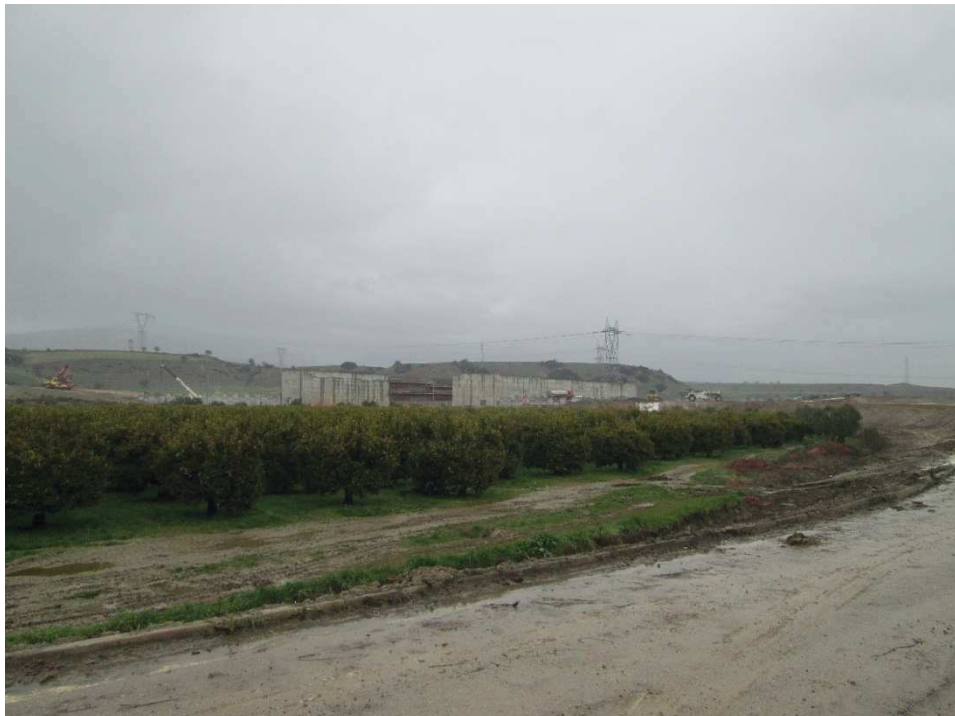
Vista 6 – Terre armate in fase di realizzazione e rampa dello svincolo di Torre Mordillo (SV03) senza manto stradale
