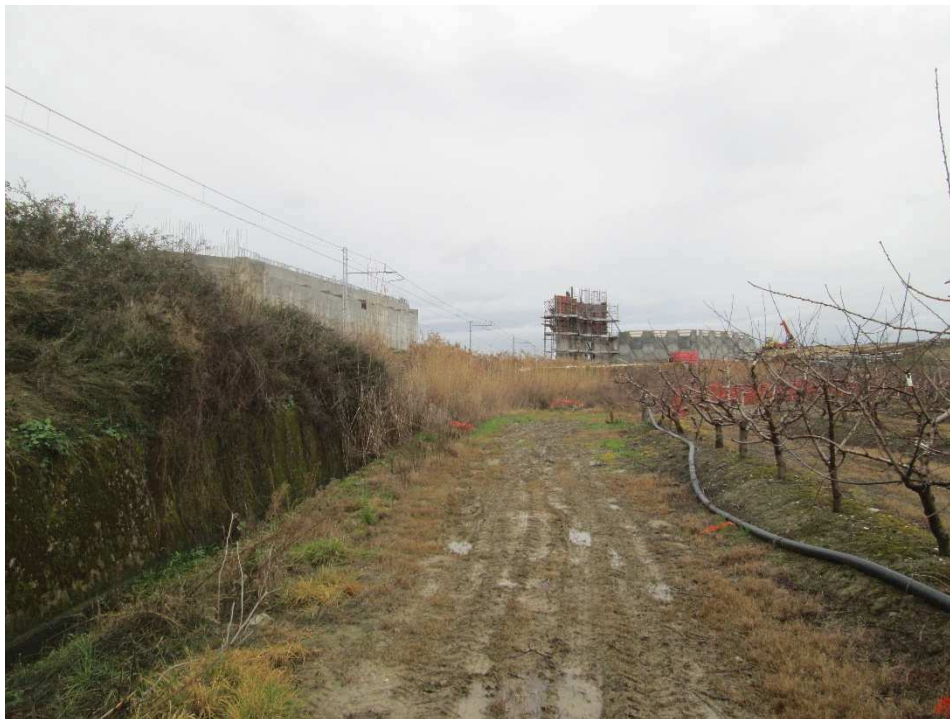
Vista 1 – Spalle in fase di realizzazione del nuovo Cavalcaferrovia
