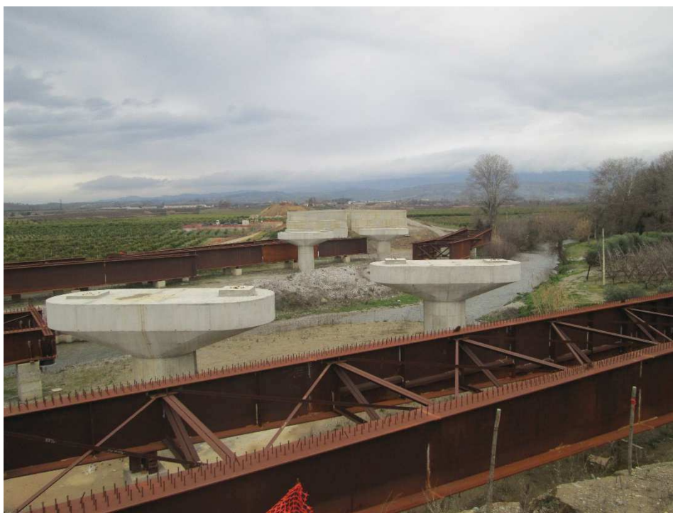
Vista 4 - Punto panoramico della zona sul Fiume Coscile. In primo piano si può vedere si osserva l'area golenale cantierizzata (presente anche vegetazione spontanea lungo le sponde del fiume), le diverse porzioni di impalcato del viadotto, le pile e le spalle sulla sponda destra del fiume. Sullo sfondo si intravede parte della SS534.
