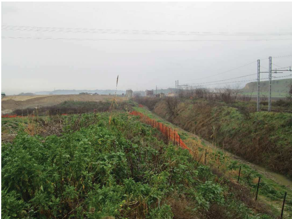
Vista 8 – Corpo del rilevato ferroviario ai margini delle aree di cantiere e che interferisce sullo sfondo con il tracciato della SS534. Nella parte centrale della foto si può osservare il corpo stradale della SS534 in fase di realizzazione
