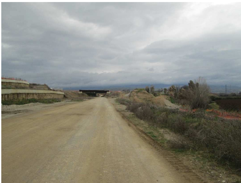
Vista 4 – Corpo stradale della SS534 in fase di ampliamento, privo di pavimentazione. A sinistra si osservano le opere di contenimento del versante (paratie tipo berlinese). Sullo sfondo si intravede l'impalcato del nuovo cavalcavia (CV02) della SS19 sulla SS534
