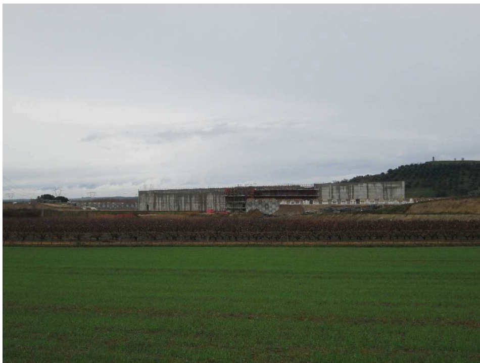
Vista 2 – Zona del Cavalcaferrovia dove si può intravedere anche la realizzazione delle terre armate a tergo delle spalle.
