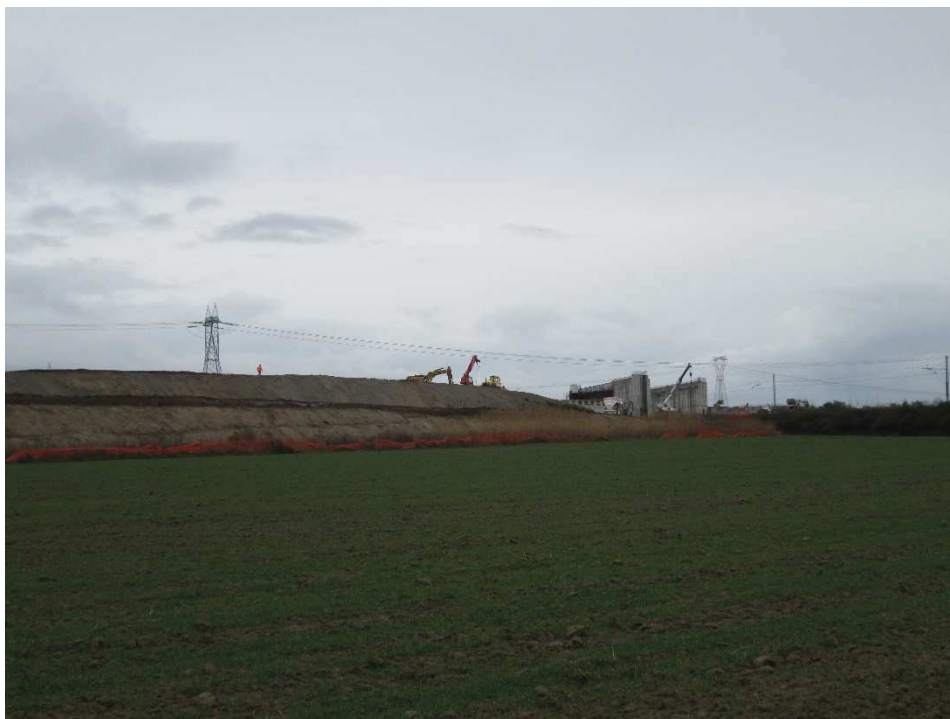
Vista 4 – Sulla sinistra della foto si osserva parte del corpo stradale della vecchia sede stradale e le lavorazioni per la realizzazione delle terre armate a tergo delle spalle.
