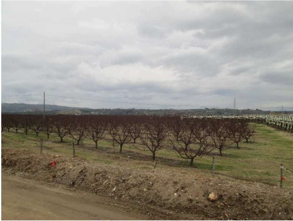
Vista 1 – Frutteti adiacenti all'area di cantiere presso la Rampa D dello svincolo SV02. La pavimentazione stradale è stata rimossa, per le successive operazioni di rettifica planimetrica dell'asse stradale
