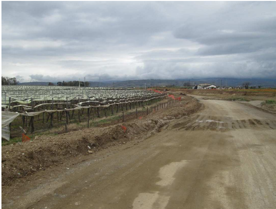
Vista 3 - Rampa D dello svincolo SV02. La pavimentazione stradale è stata rimossa, per le successive operazioni di rettifica planimetrica dell'asse stradale. Sullo sfondo è presente la sede stradale ampliata della SS534, anch'essa priva di pavimentazione stradale. Rimossi anche i muretti a bordo strada della SS534
