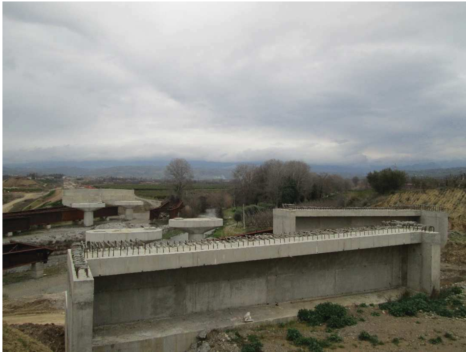
Vista 5 – Punto panoramico della zona sul Fiume Coscile. In primo piano si può vedere la spalla lato Sibari della Carreggiata in direzione Sibari. Nella zona retrostante si osserva l'area golenale cantierizzata (presente anche vegetazione spontanea lungo le sponde del fiume), le diverse porzioni di impalcato del viadotto, le pile e le spalle sulla sponda destra del fiume. Sullo sfondo si intravede parte della SS534.
