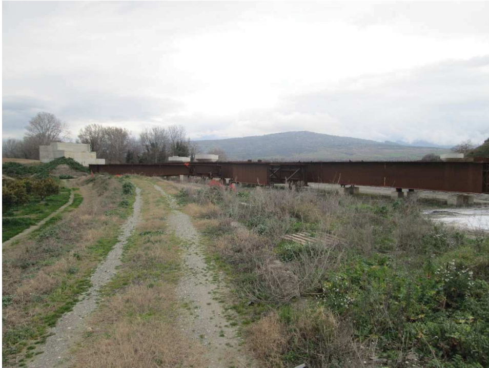
Vista 1 – Zona a valle delle spalle lato Sibari ed adiacente all'area golenale del Fiume Coscile (sponda destra). Si possono osservare le porzioni dell'impalcato in acciaio e le pile.
