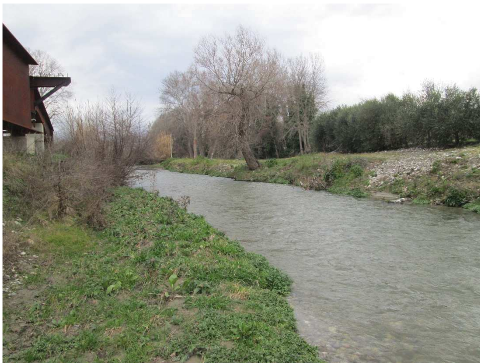
Vista 4 – Letto del Fiume Coscile con vegetazione spontanea sulle sponde. Sulla sinistra della foto, si osserva parte dell'impalcato del nuovo viadotto, mentre la zona a destra (uliveto) non è interessata dalle lavorazioni
