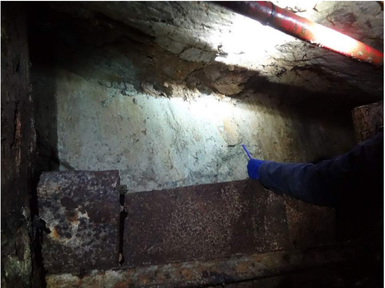
Piano di faglia della linea tettonica "Grem" che corre parallelamente all'asse della galleria Riso Parina.
