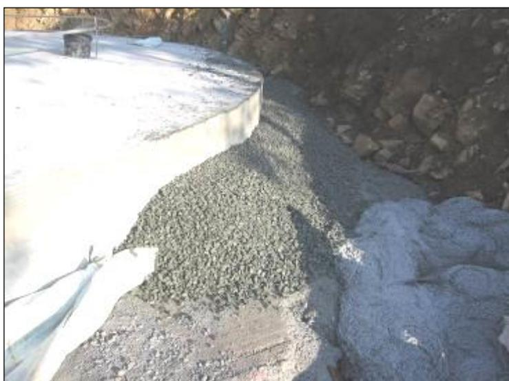
Figura 74 - Realizzazione del drenaggio al piede della fondazione
