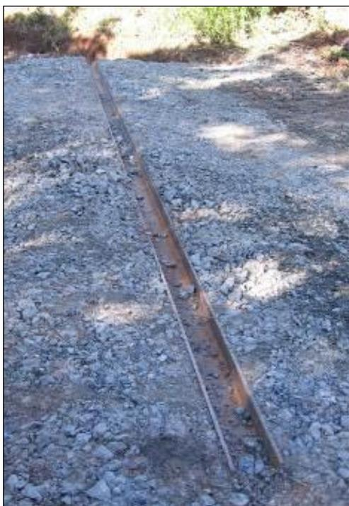
*Figura 70: Esempio di schiva trasversale alla sezione stradale*
