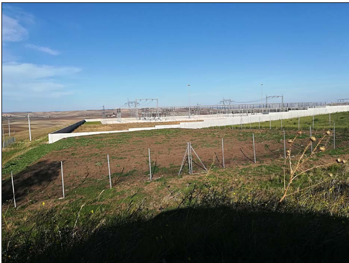
Figura 4 – Area della Cabina primaria di Genzano, nei pressi dell'area che secondo STMG ospiterà lo stallo RC Wind
