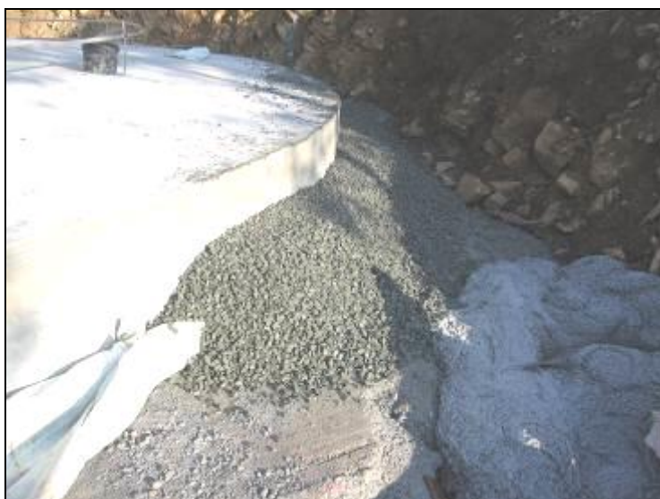
Figura 71 - Realizzazione del drenaggio al piede della fondazione
