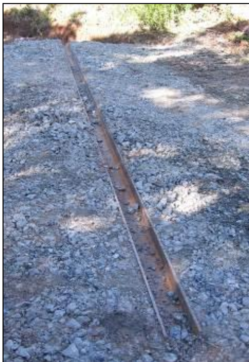
Figura 67: Esempio di schiva trasversale alla sezione stradale
