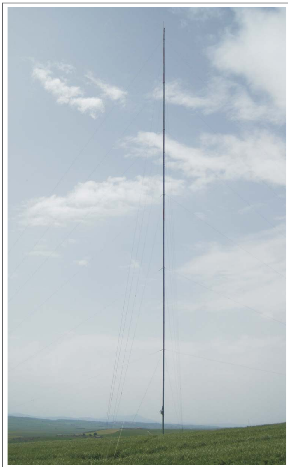
La stazione vista da Est
