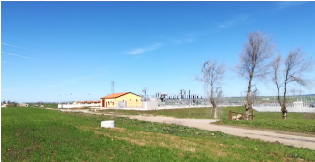
Figura 12: Area della sottostazione elettrica
