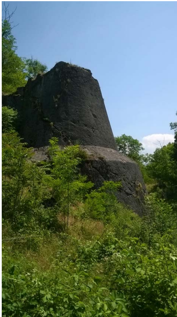
Fig. 5 – bastione della fortezza sabauda situata sul Podio, scavato nella roccia.
