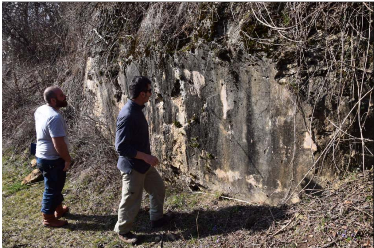
Figura 5b - Affioramento di Carniole in cui è presente il piano di faglia F1.
