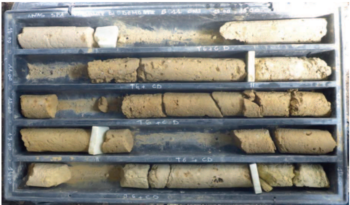
Figura 15: Carnioli associate all'unità geotecnica UGm3 in quanto caratterizzate da un elevato grado di alterazione.
