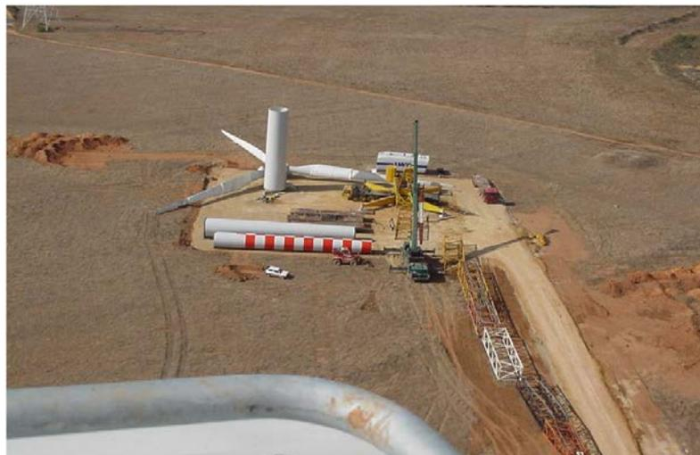
Foto 1. Piazzola per il montaggio dell'aerogeneratore
