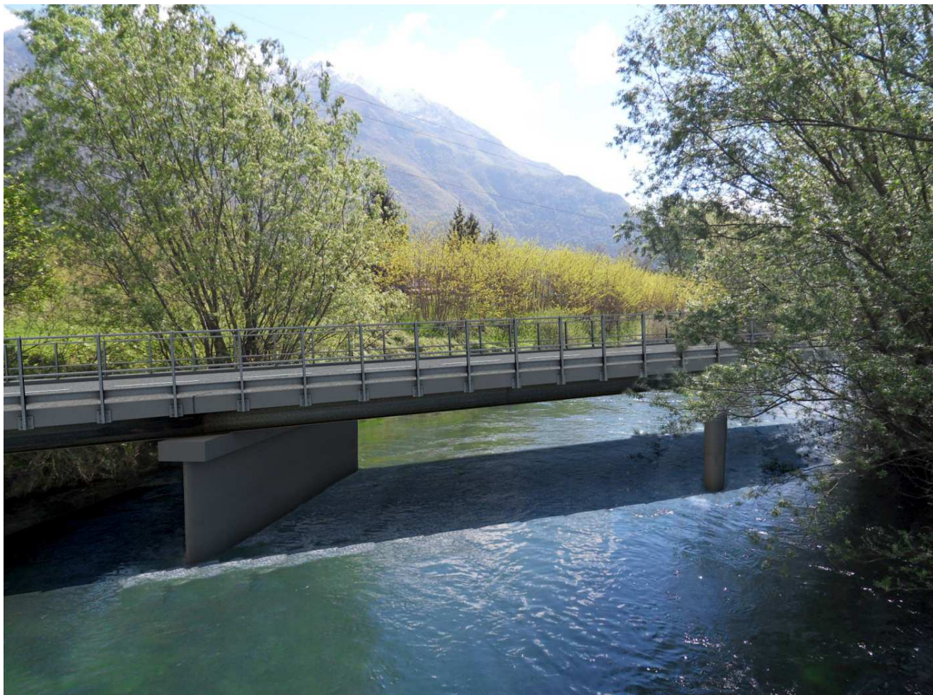
Fig.4 - Foto inserimento del ponte visto dal canale di scarico
