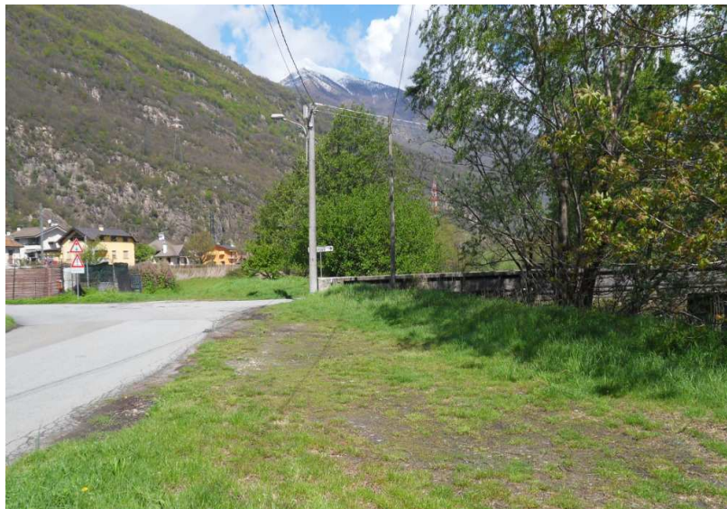
Fig.3 - strada comunale della Lisca che accede al ponte lungo la riva sinistra idraulica del canale artificiale
