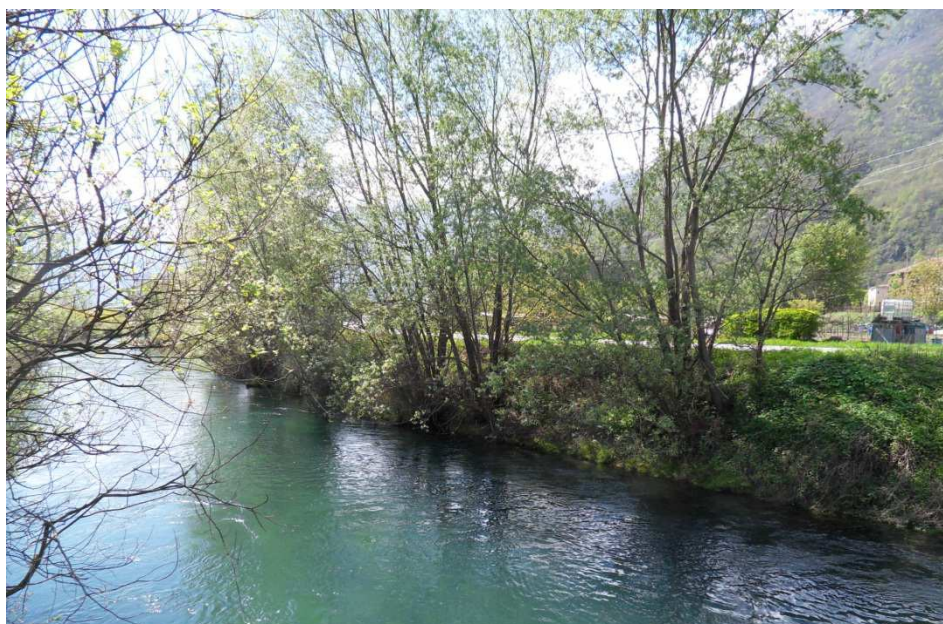
Fig.2 – Canale di scarico della Centrale Idroelettrica ENEL di Pallanzeno
