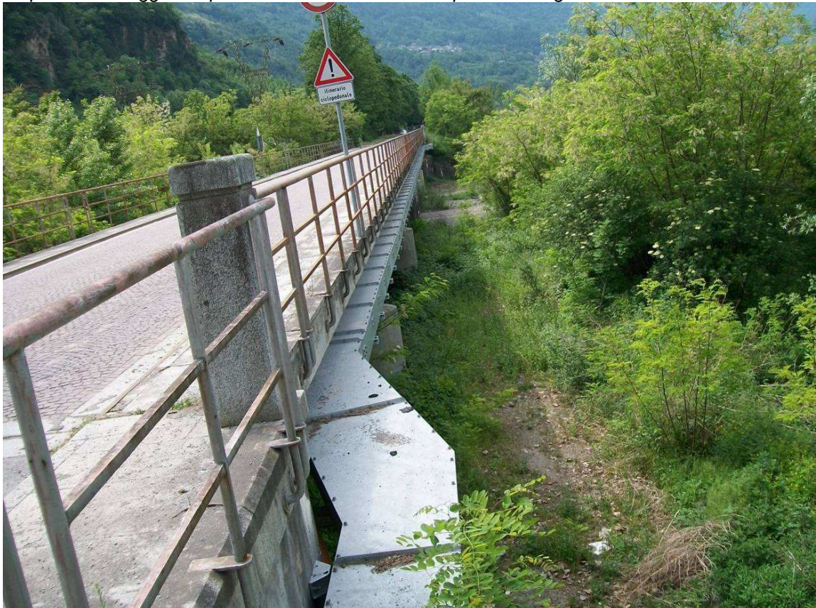
Esempio di ancoraggio di tipo "scatolare"
