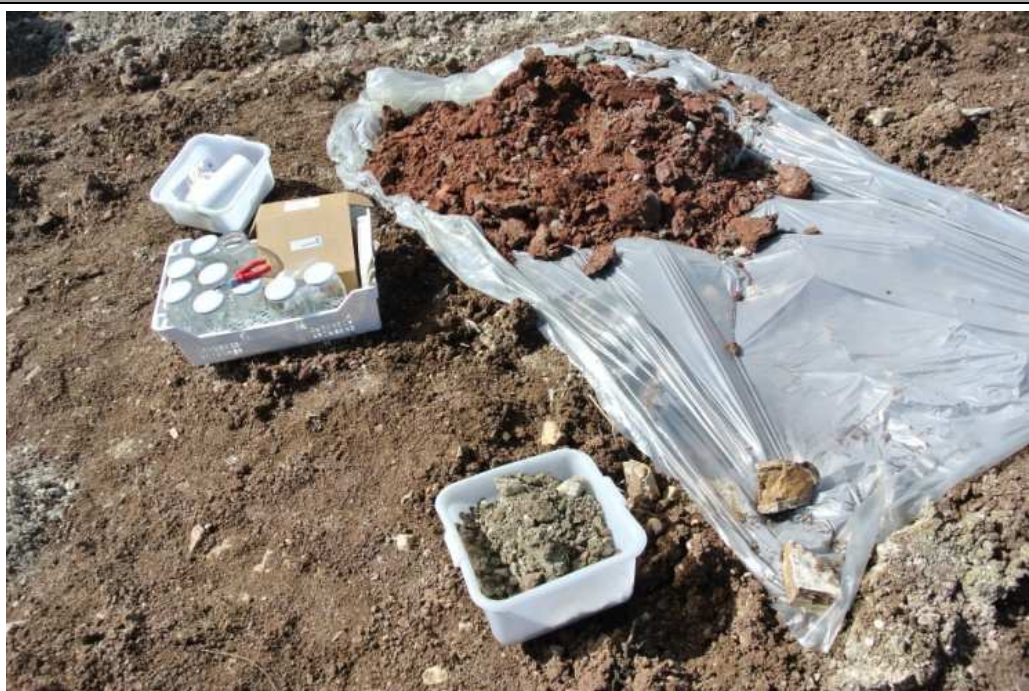
Deposito materiale scavato
