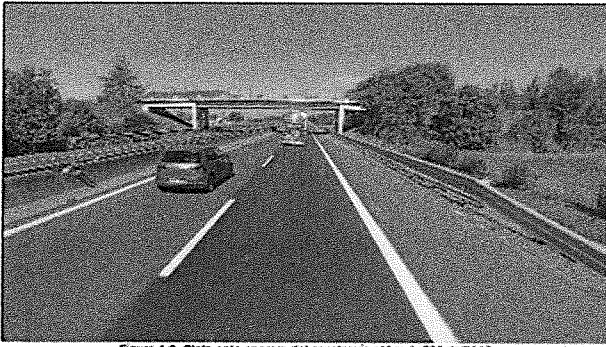
Figura 1.2. Stato ante operam del cavalcavia al km 4+500 dell'A13
