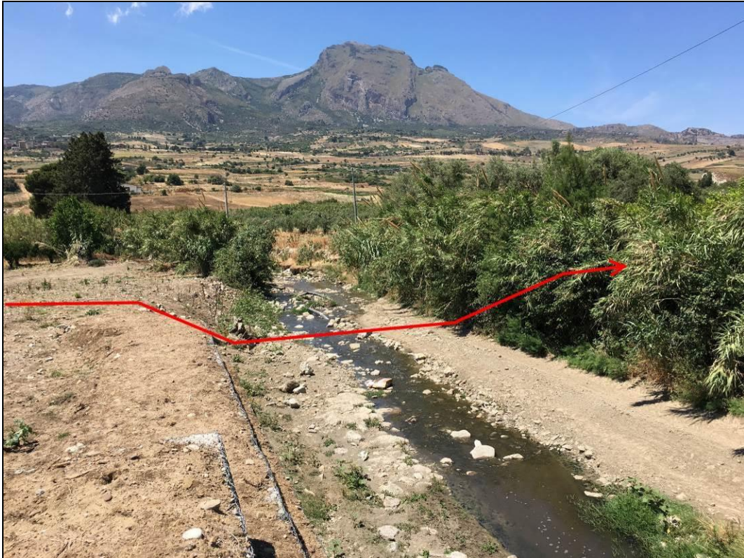
Fig.3.2/A: Foto ambito di attraversamento del corso d'acqua
