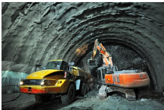
Figura 2 – Immagine esemplificativa dello scavo in tradizionale.
