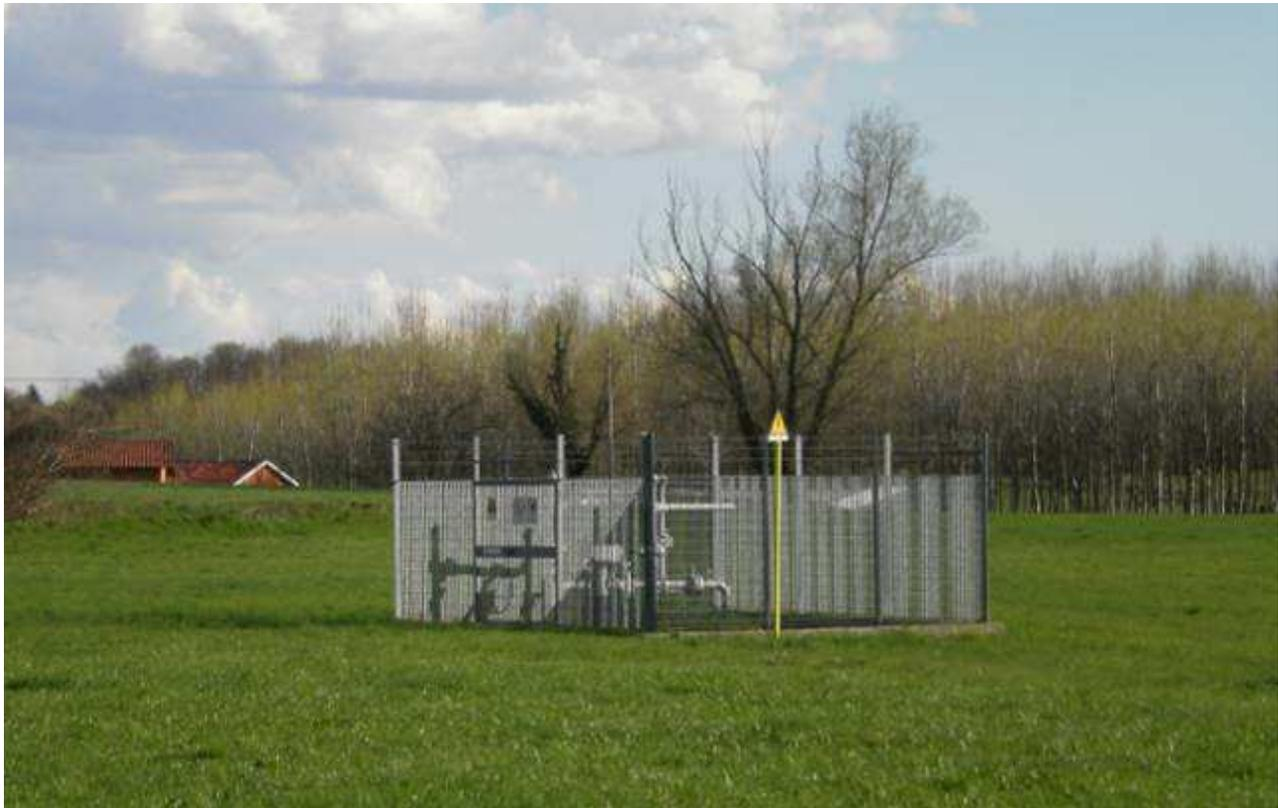
**Fig. 8.9- Esempio di Punto di Intercettazione di Derivazione Importante PIDI.**
