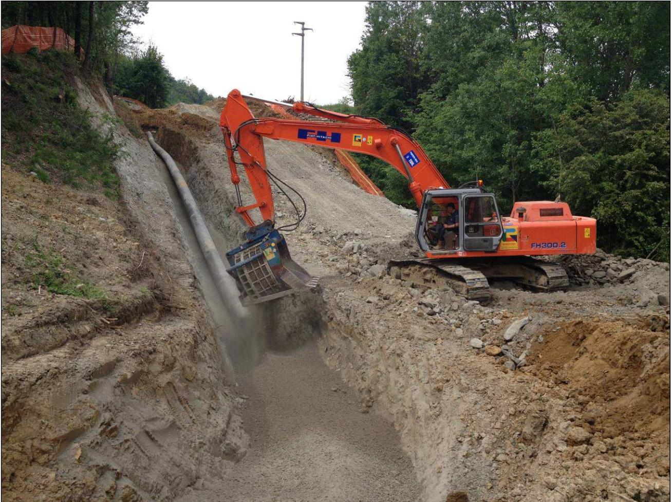
**Fig. 8.3 - Operazione di rinterro della condotta.**
