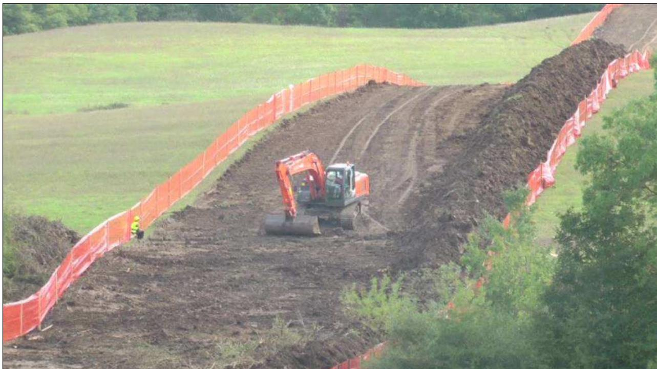
**Fig. 8.1 – Esempio di apertura pista di lavoro.**
