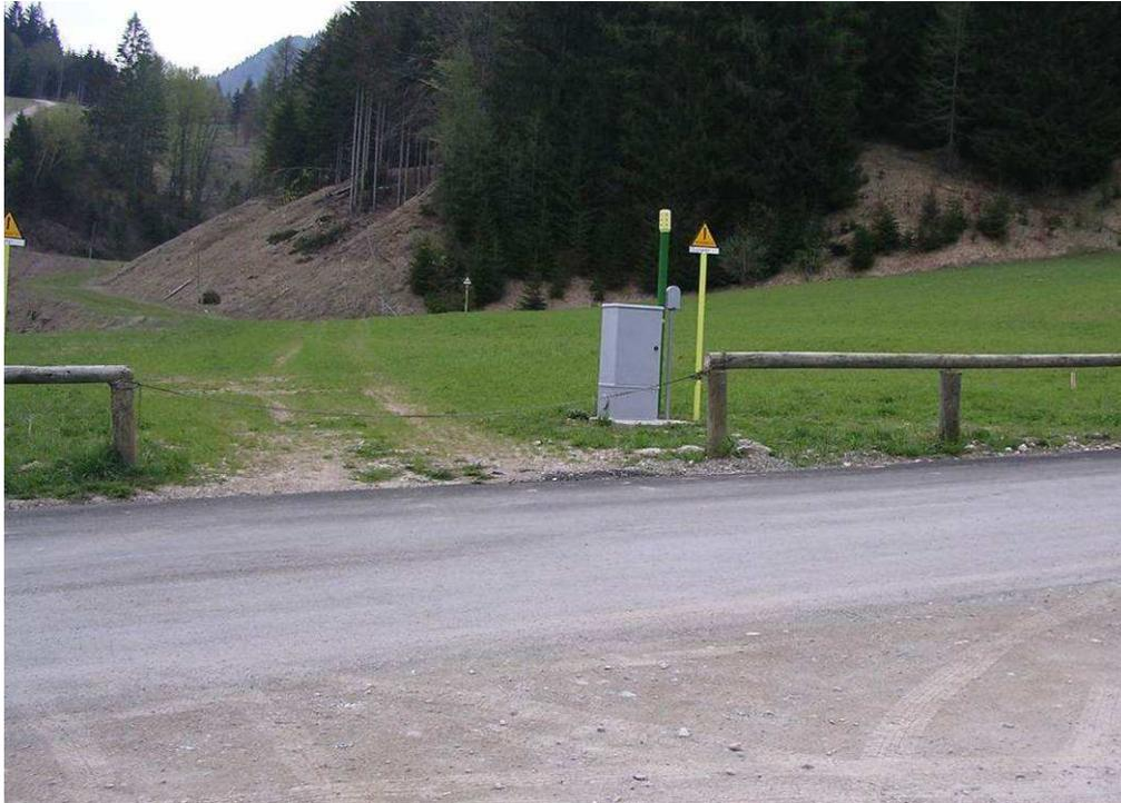
**Fig. 8.10** - I cartelli segnalatori del metanodotto ed i tubi di sfiato posti in corrispondenza degli attraversamenti eseguiti con tubo di protezione.
