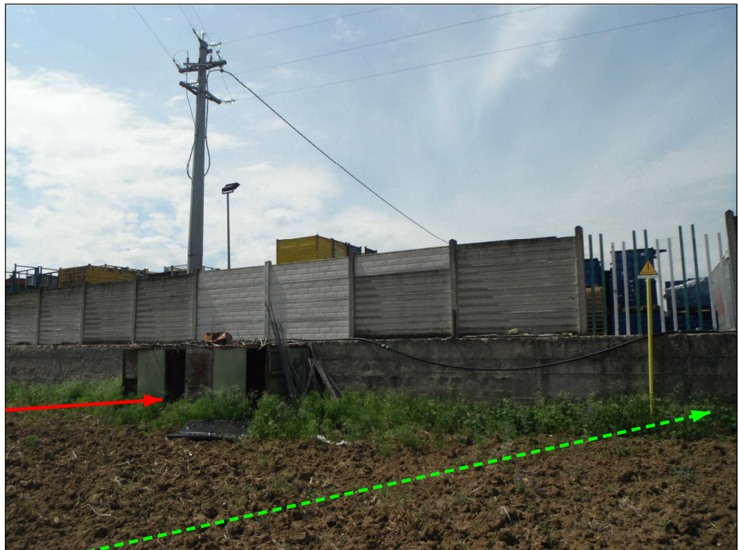
Attraversamento piazzale privato (ingresso trivellazione)
