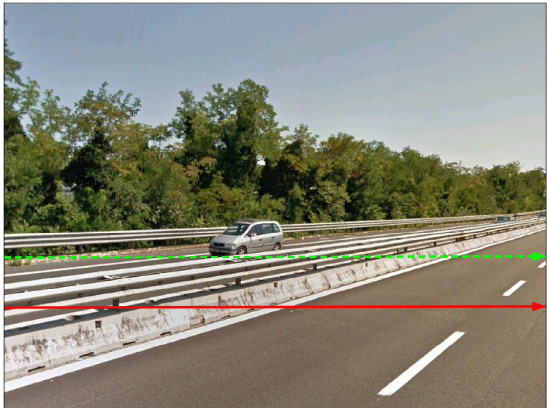
Attraversamento Autostrada A14
