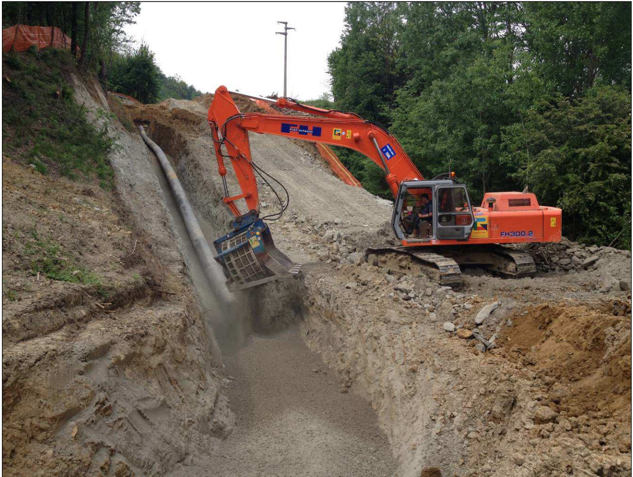
Fig. 2.6 - Operazione di rinterro della condotta.
