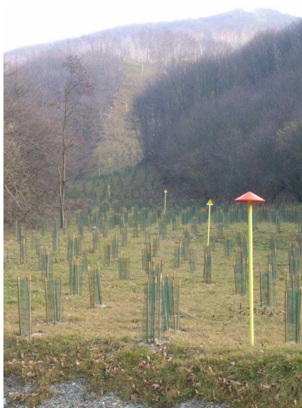
Fig. 2.14 - Cartelli segnalatori di un metanodotto posizionati lungo il tracciato e ripristino con piantumazione di essenze arboree.
