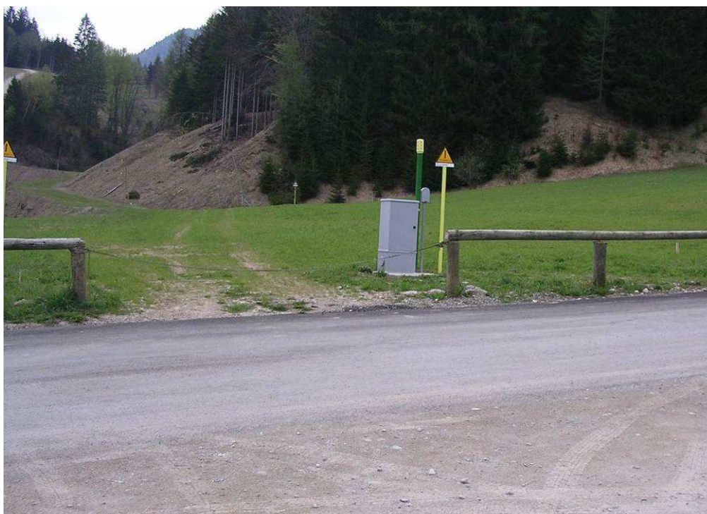
Fig. 2.13 - I cartelli segnalatori del metanodotto ed i tubi di sfiato posti in corrispondenza degli attraversamenti eseguiti con tubo di protezione.
