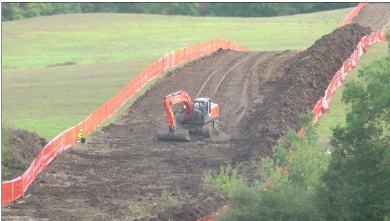
Fig. 2.4 – Esempio di apertura pista di lavoro.
