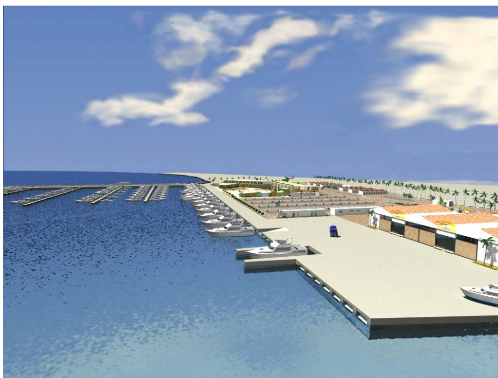
Figura 70 – Vista dal mare dopo la realizzazione della struttura portuale.
