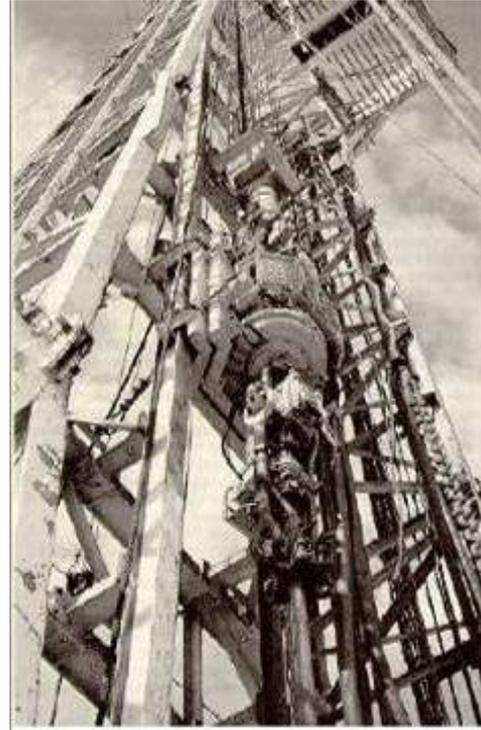
Figura 4-4: Impianto di Perforazione – Top Drive System
