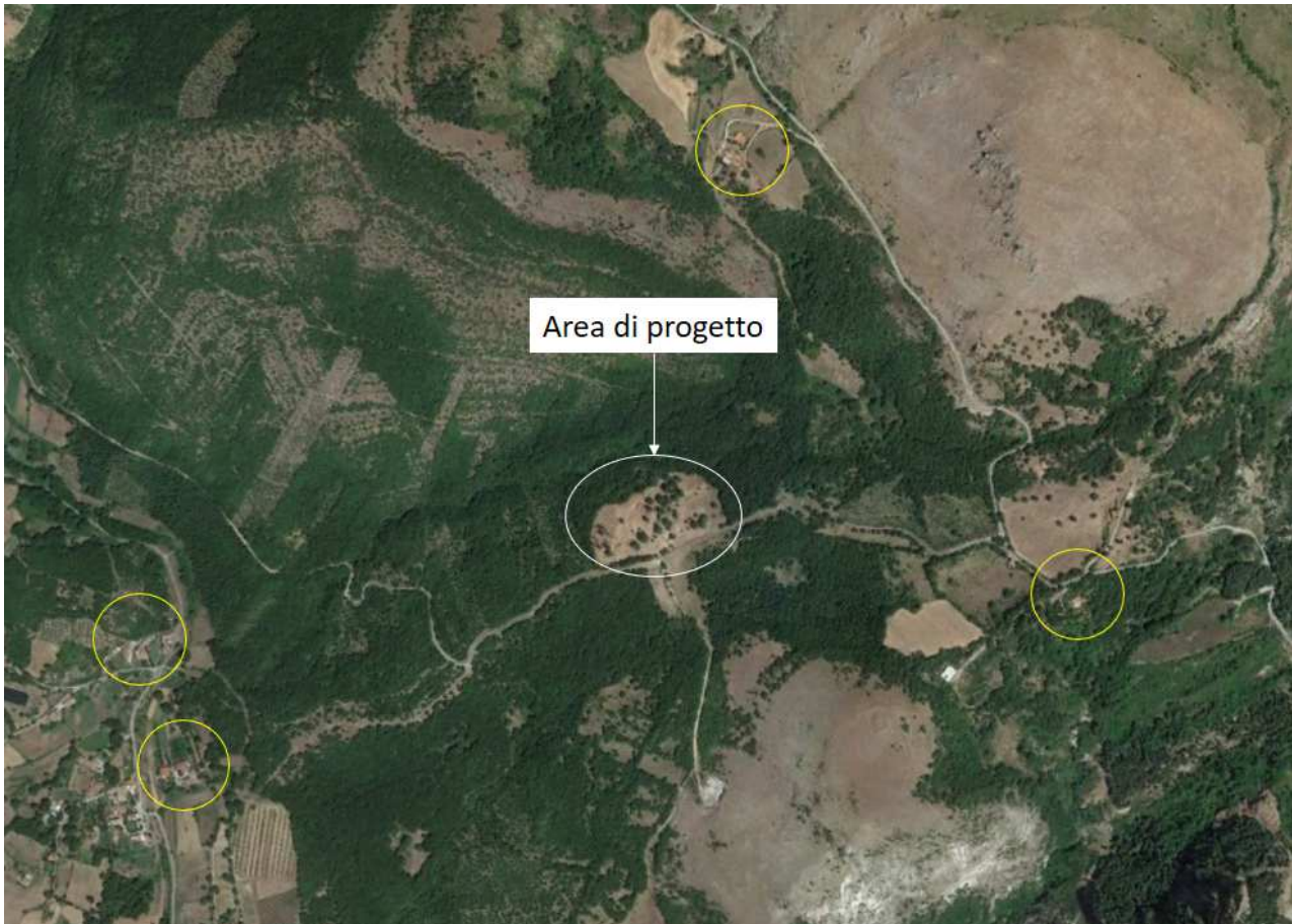
Figura 2-2: Vista dell'area con i ricettori interessati
