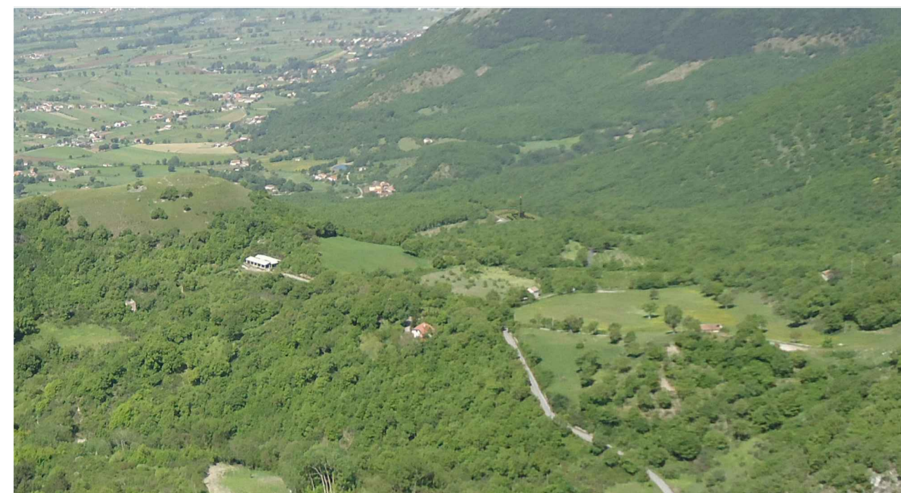
Le opere di mitigazione cromatica e ambientale mascherano visivamente l'impianto durante la fase di perforazione
