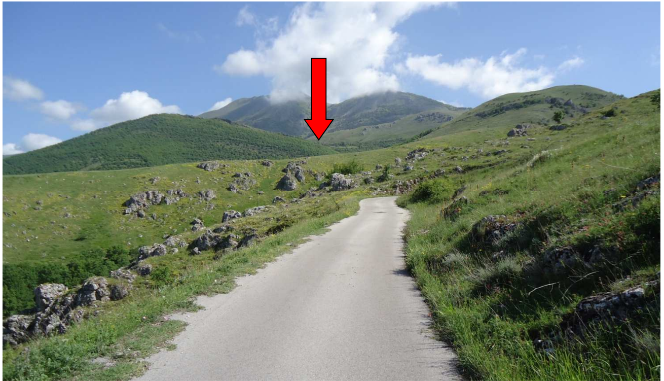
FOTO F - Strada Comunale 2ª Traversa Arenara
