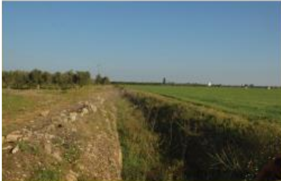
Canale di drenaggio delle acque superficiali
