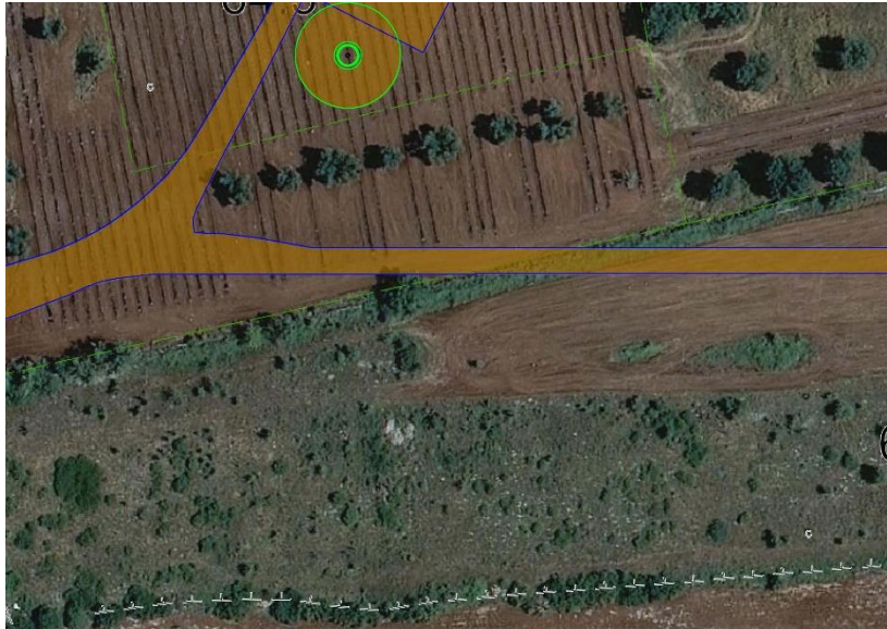
Dettaglio attraversamento muretto a secco pista di accesso WTG7 e WTG8
