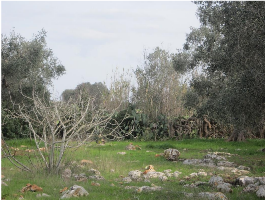
Secondo muretto a secco (strada di accesso WTG 7) visto da est nel tratto interessato dalla viabilità di progetto
