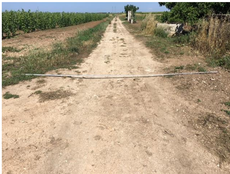
Strada interpoderale di accesso alla WTG5. L'asta metrica ha una lunghezza di 5 m, come evidente dalla foto è possibile un allargamento a destra e sinistra della strada senza generare interferenze
