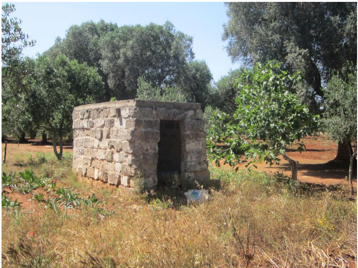
Manufatto G – Deposito attrezzi agricoli privo di finestre
