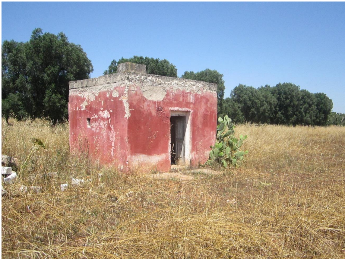
Manufatto H – Deposito attrezzi agricoli privo di finestre
