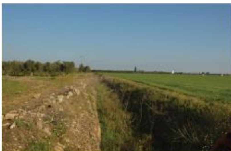
Canale di drenaggio delle acque superficiali
