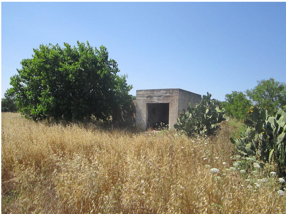
Manufatto I – Deposito attrezzi agricoli privo di finestre
