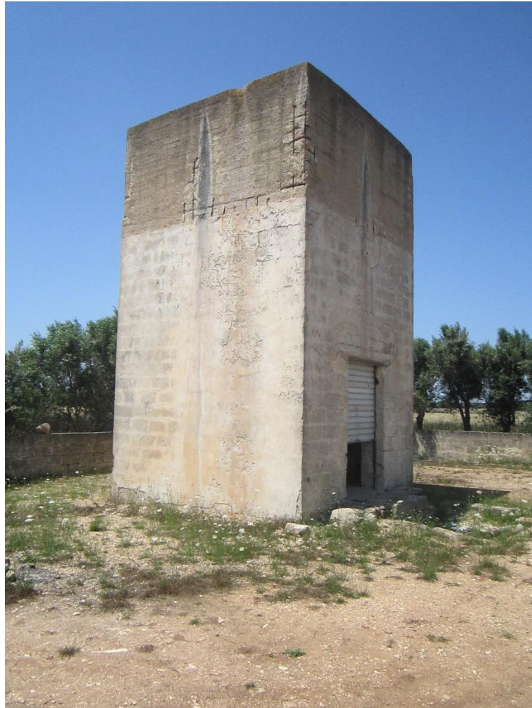
Manufatto B – Locale pompe pozzo artesiano con vasca di accumulo nella parte superiore
