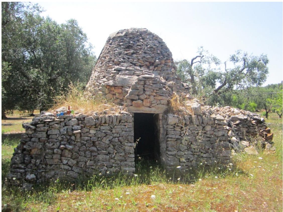
Manufatto E – Tipica costruzione rurale in pietre a secco non abitabile
