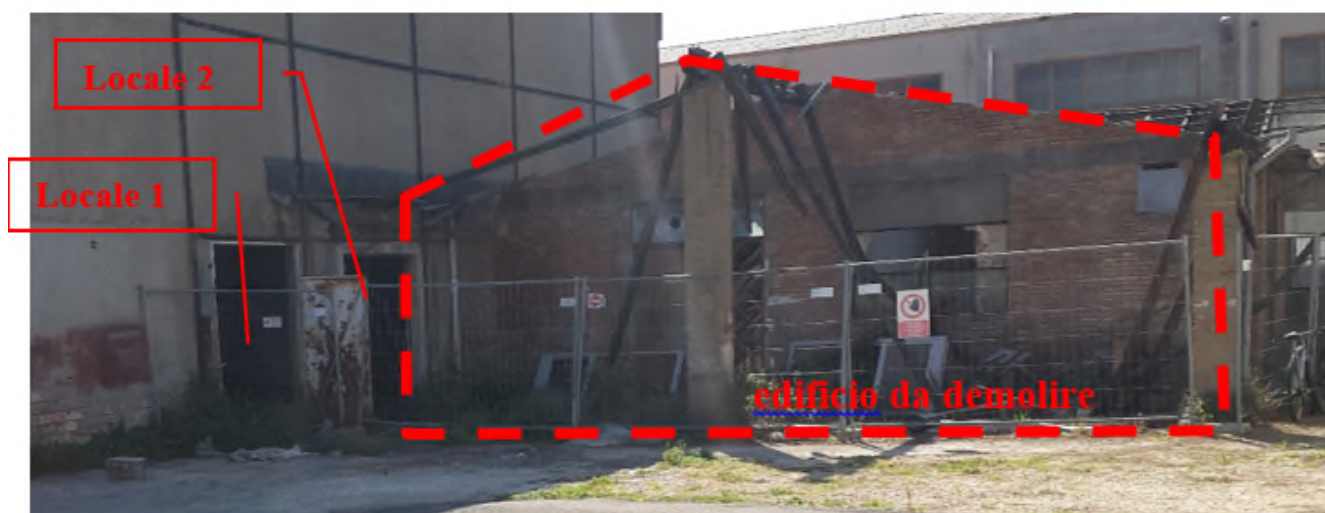
Figura 3-17 - Stato di fatto dell'Edificio ex magazzino da demolire
