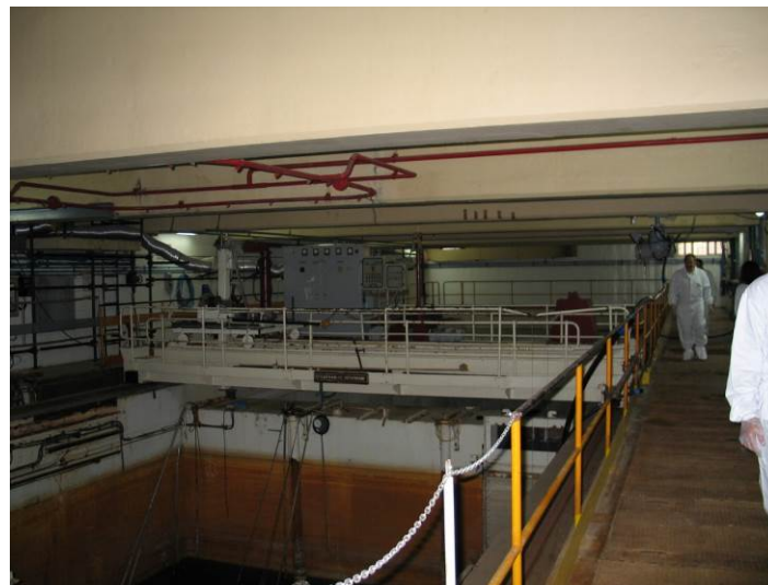
Figura 10: Edificio Pond: Gru Cesti.
