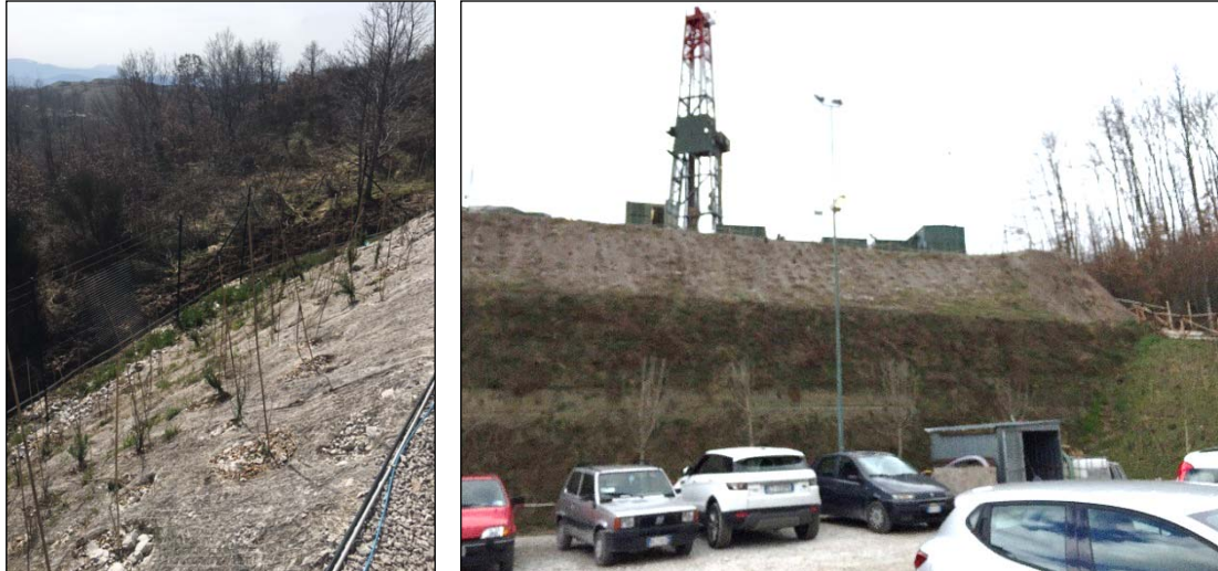
Muro di contenimento in terre armate e facciata ricoperta con biostuoie.
