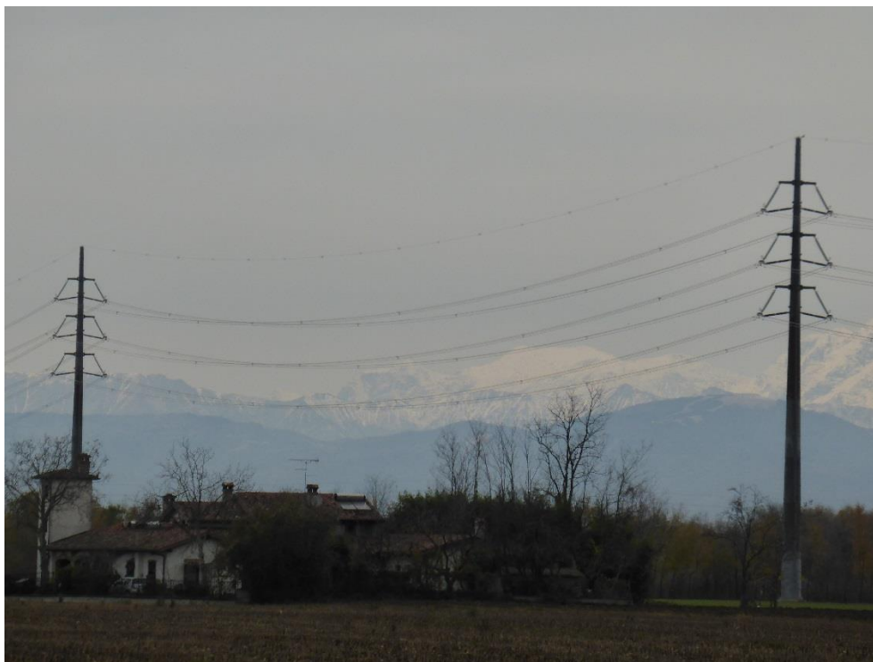
Installazione spirali su campate sost. 41 (96) - a sinistra (non in foto), nn. 42 (97) e 43 (98) in foto
