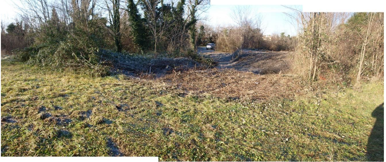
Demolizione Linea 220kV – Sostegno n.92 – Confermata possibilità di formazione prato Villesse
