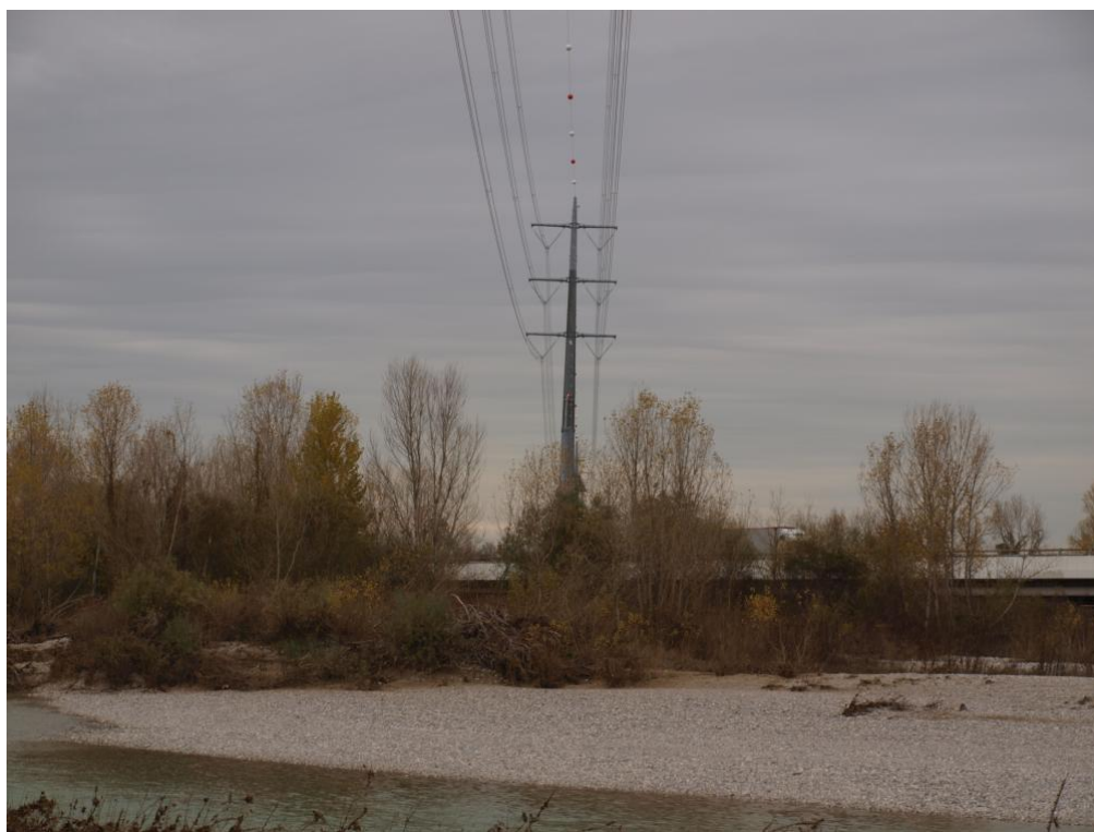
Panoramica attraversamento F. Isonzo con apposte sfere di segnalazione senza verniciatura sostegni
