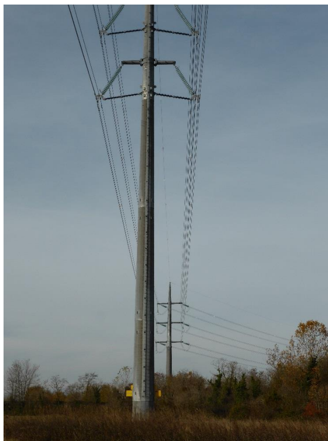
Installazione spirali su campata sost. 31-32
