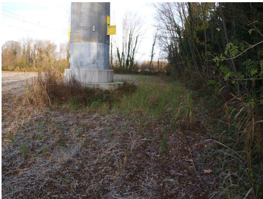
Sostegno n° 4 – Previsto prato. Restituzione a coltivo già effettuata
