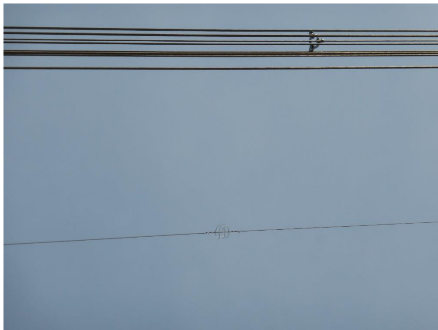
Dettaglio spirale installata
