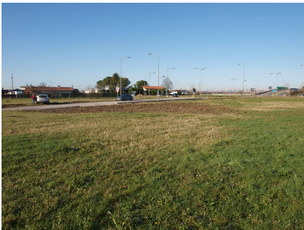
Demolizione Linea 220kV – Sostegno n.90 - Confermata possibilità di formazione prato - Villesse
