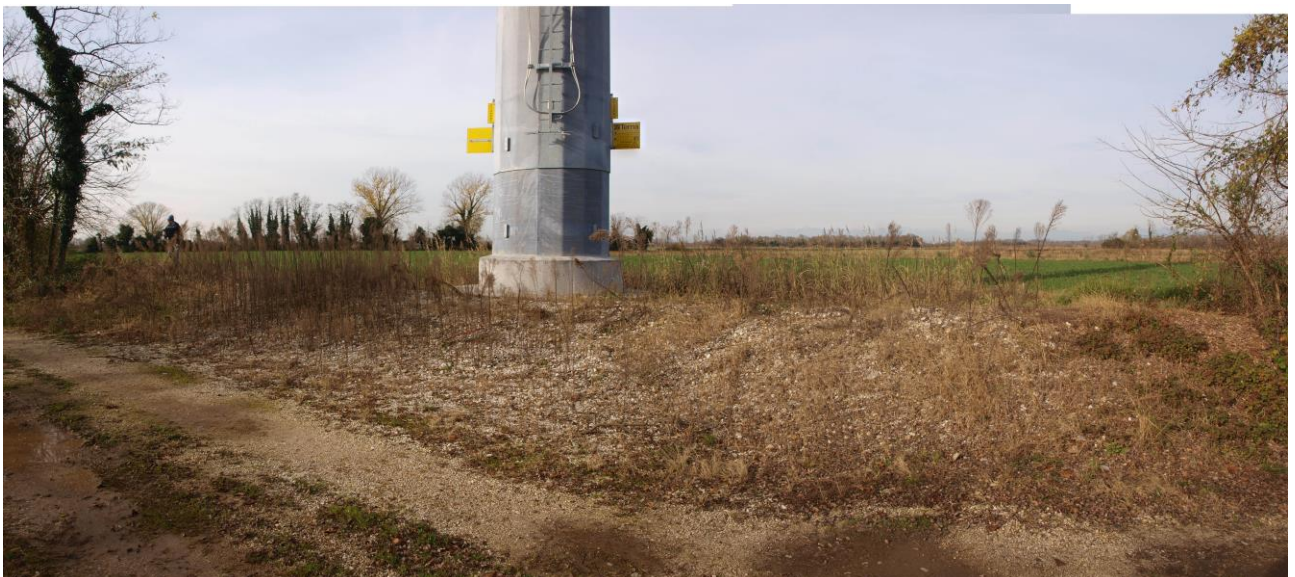
Sostegno n° 41 – Previsto prato. Si ritiene di poter migliorare il prog. ripristino con la possibilità di formazione siepe ad arbusti per ripristinare la continuità della siepe preesistente
