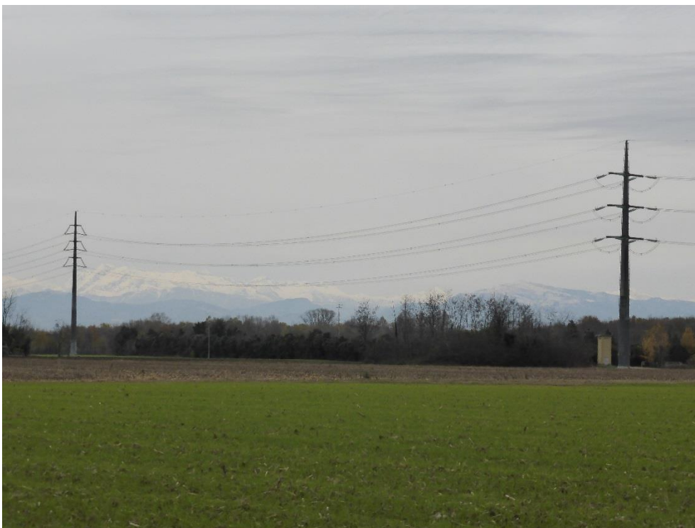
Installazione spirali su campata sost. 43 (98) e 44 (99)
