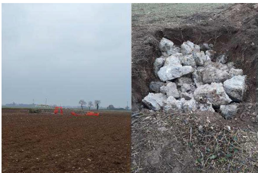
Demolizione sostegno n.88 e demolizione fondazione della linea 132kV Istrago-Meduna
