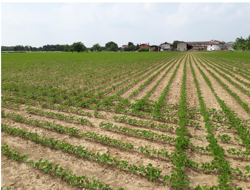
Demolizione Linea 220kV – Sostegno n.50 – Area già ripristinata e restituita a coltivo da parte del proprietario
