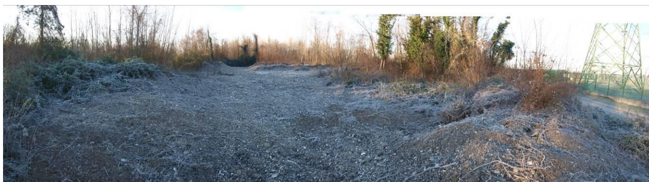
Demolizione Linea 220kV – Sostegno n.99 - S. Pier d'Isonzo (presso S.E. Redipuglia) – Confermata possibilità di formazione prato previa fresatura
