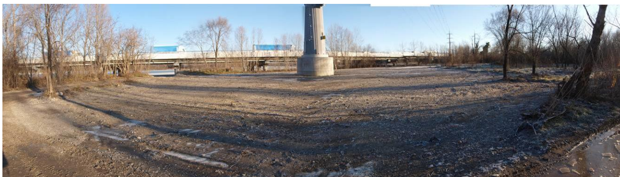
Sostegno n. 56 – F. Isonzo – Confermata possibilità di ricostruzione prato previo riporto terreno vegetale
