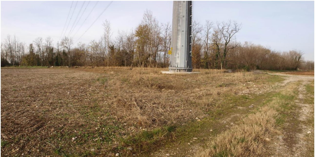
Sostegno n° 36 – Previsto Prato. Si ritiene di poter migliorare il prog. ripristino con la possibilità di formazione prato “stabile” con fiorume in paglia previa sfalcio invasive (250 mq circa)
