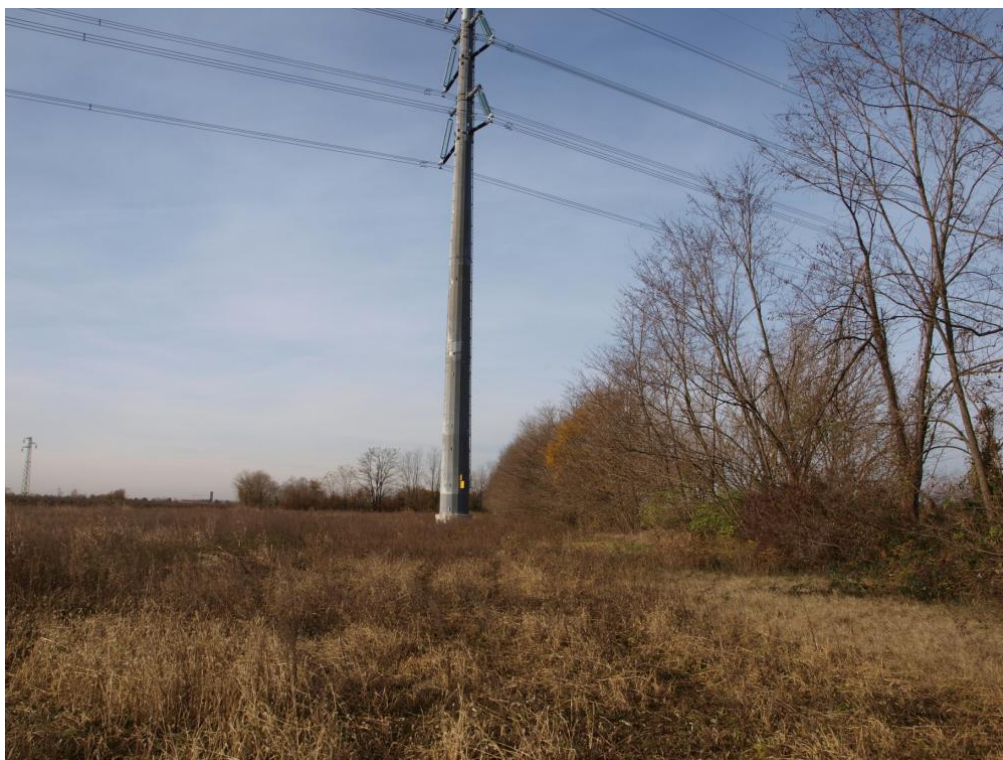
Sostegno n° 28 – Confermata possibilità di formazione prato su campo (apparentemente abbandonato) e di prevedere contestualmente, migliorando il prog. di ripristino, il mantenimento della siepe arbustiva esterna
