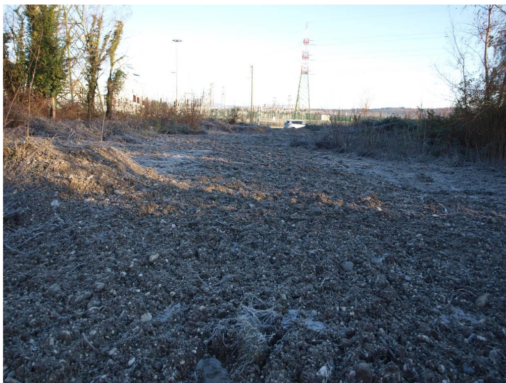
Demolizione Linea 380kV Planais- Redipuglia – Sostegno n.186 - presso S. Pier d'Isonzo- Confermata possibilità di formazione prato
