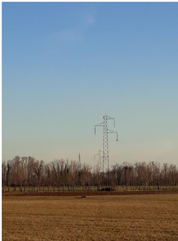
Rimozione conduttori tratta 88-99 della linea 132kV Istrago-Meduna
