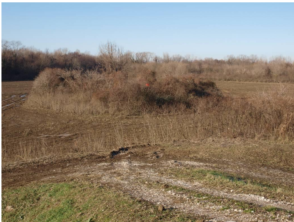
Demolizione Linea 220kV – Sostegno n.85 – Confermata possibilità di ricostruzione area boscata
