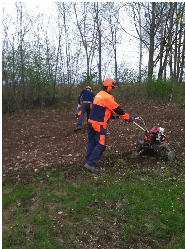
Preparazione terreno per semina a seguito demolizione sost. 94 della linea 132kV Istrago-Meduna
