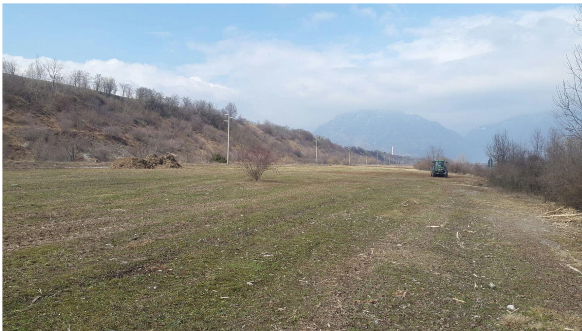
Esecuzione dei lavori di trinciatura degli arbusti di Amorpha fruticosa ed accumulo della biomassa legnosa
