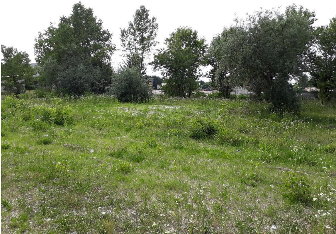
Demolizione Linea 220kV – Sostegno n° 94 da demolire – Confermata possibilità di ripristino a prato. Sulla base delle considerazioni della Regione sarà evitato il ripristino a prateria arida in quanto il prato è stato da tempo trasformato.
