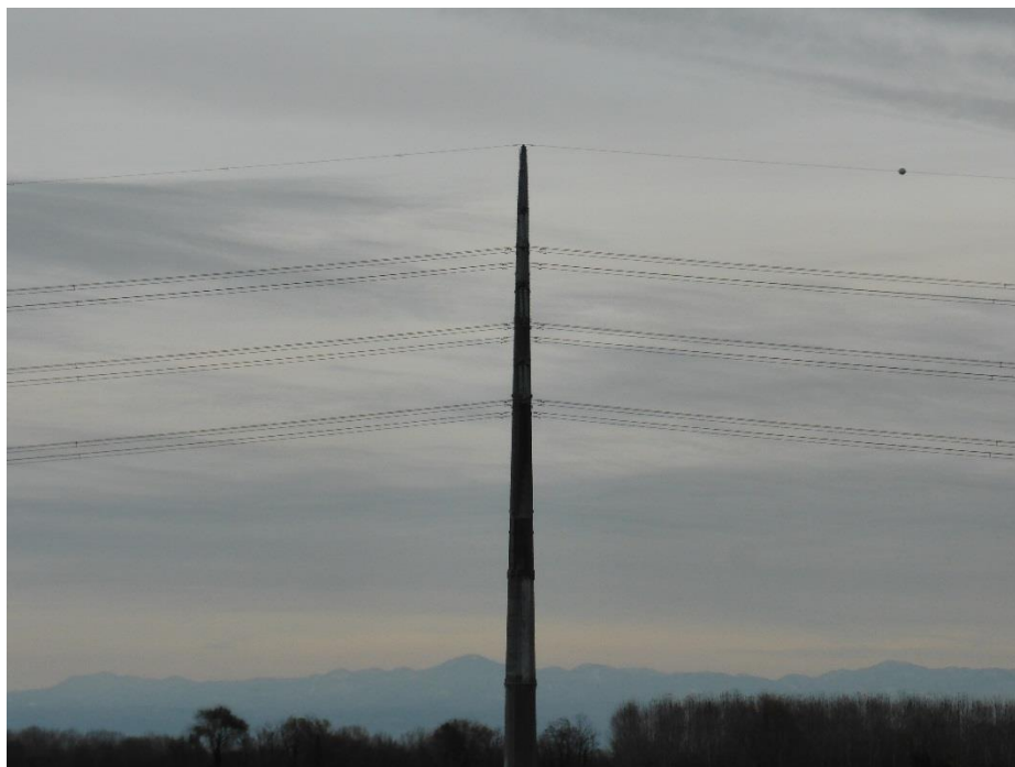
Installazione spirali su campata sost. 44 (99) e 45 (100) – quello in foto; dalla campata successiva si noti l'installazione di sfere di segnalazione aeronautica (fino alla SE Redipuglia)
