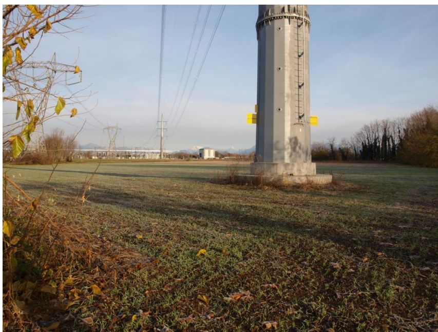
Sostegno n° 2 – Previsto prato. Restituzione a coltivo già effettuata
