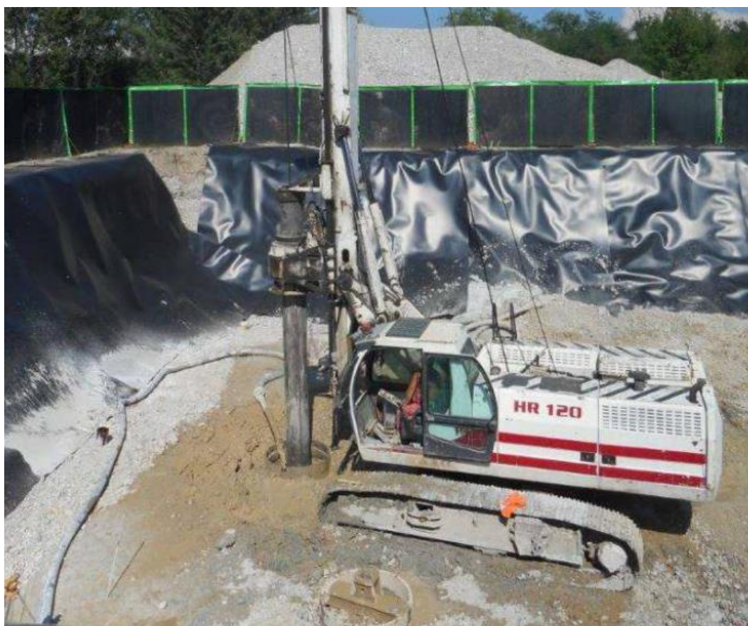
Tratta 3: Sostegno 56 – esecuzione pali trivellati (si noti la recinzione con pannelli fonoassorbenti intorno ai mezzi operanti nel cantiere e le Misure di messa in sicurezza adottate in accordo con ARPA per evitare la dispersione delle polveri) – luglio 2017
