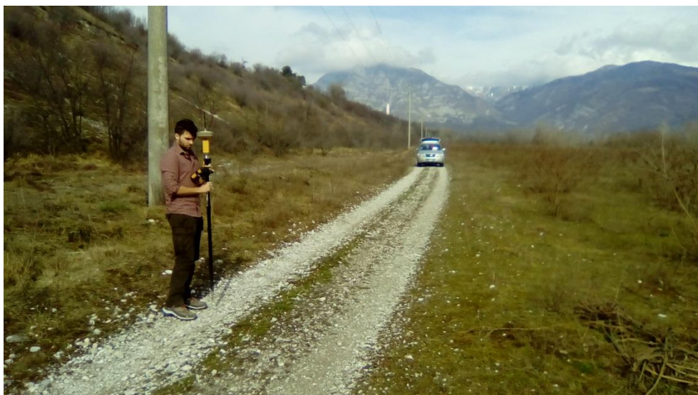
Fase di esecuzione del rilievo topografico
