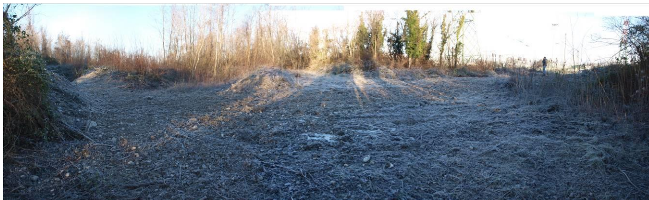
Demolizione Linea 220kV – Sostegno n.98 - S. Pier d'Isonzo (presso S.E. Redipuglia) - Confermata possibilità di formazione prato previa fresatura
