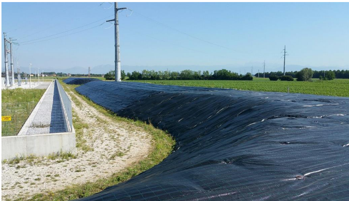
Sistemazione dei teli (giugno/luglio 2017)
