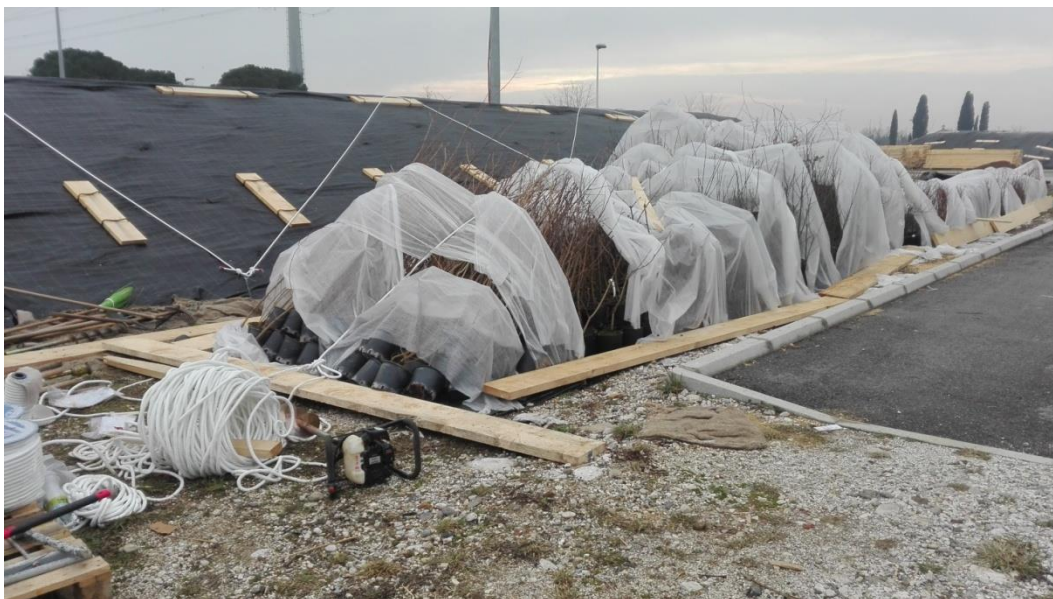
Copertura con TNT per difesa antigelo piante in vaso di arbusti ed alberi a piè d'opera prima dell'impianto (gennaio 2017)
