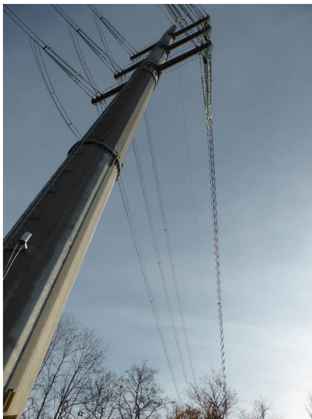
Installazione spirali su campata sost. 30-31
