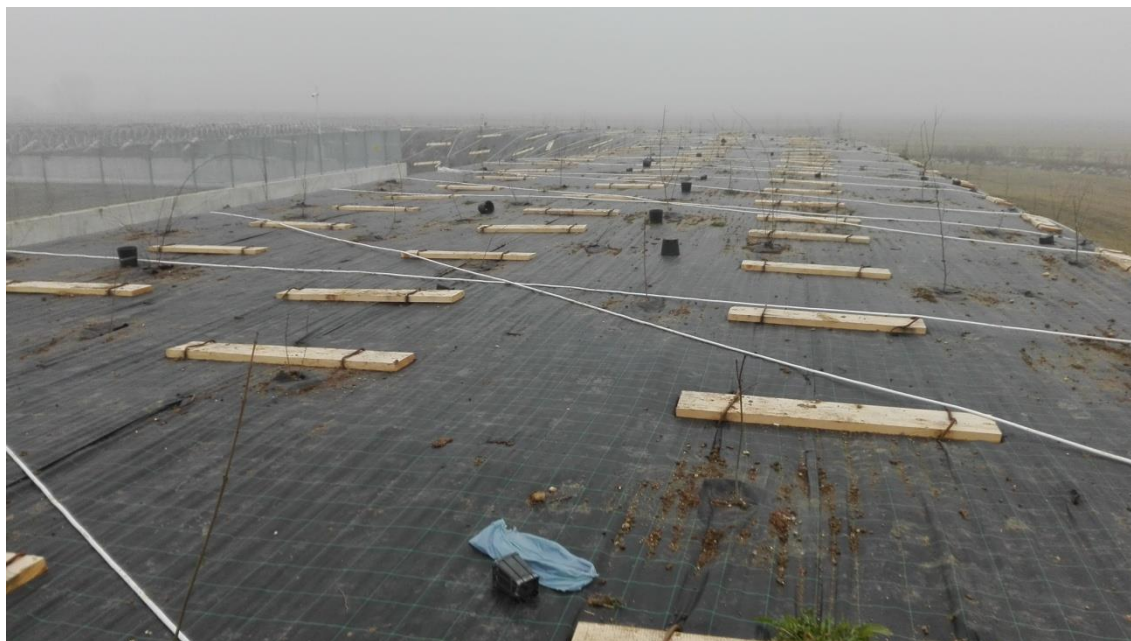
Messa a dimora degli alberi e arbusti sul rilevato di stazione quasi terminata (inizio febbraio 2017).
