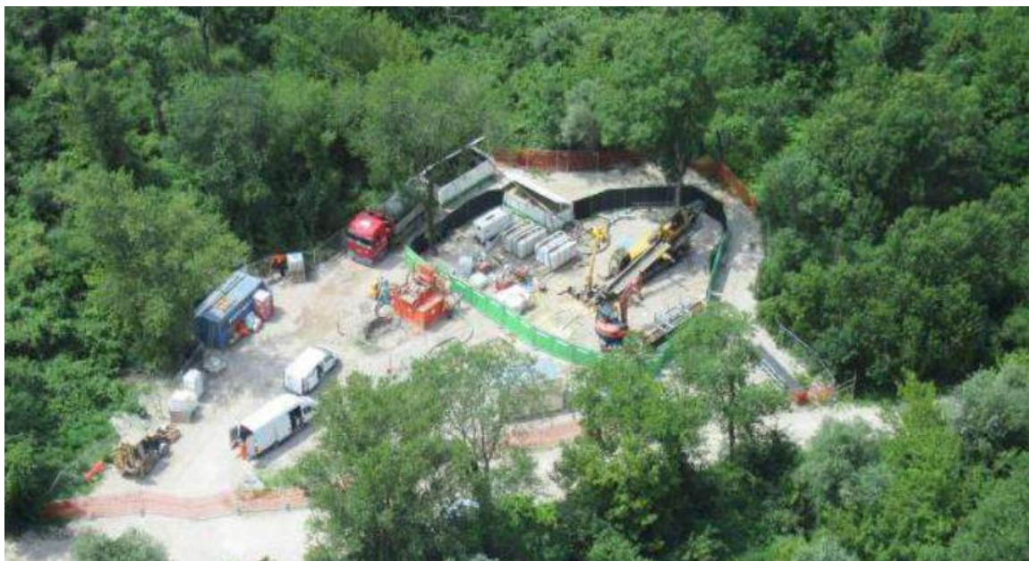
Cantiere TOC per il cavo interrato Schiavetti-Redipuglia (si noti la recinzione con pannelli fonoassorbenti)
