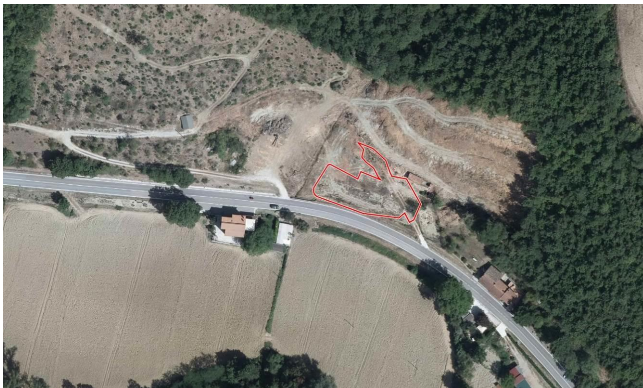
FIGURA 4-33 FOTOPIANO CON INDIVIDUAZIONE DEL CANTIERE "F"
