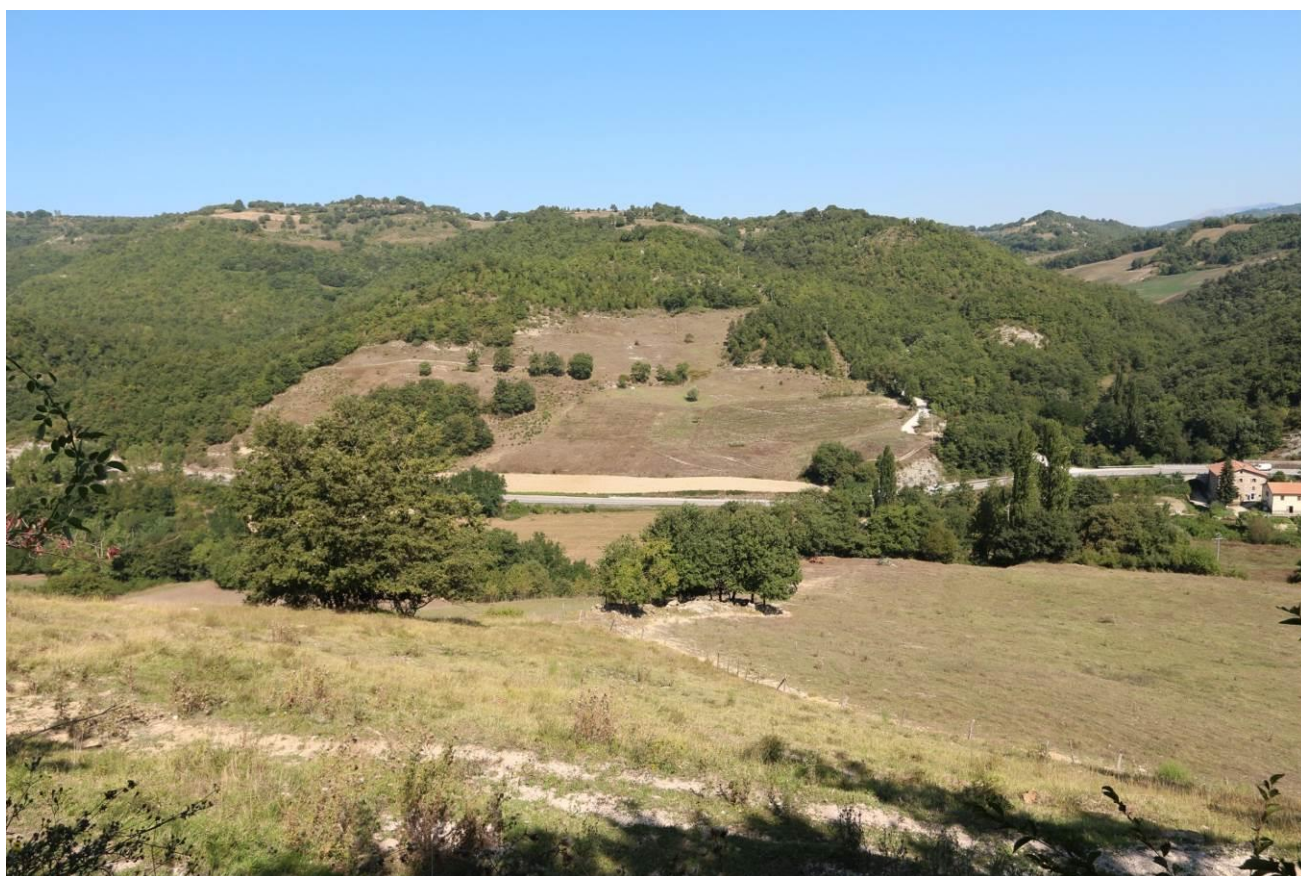
FIGURA 4-15 RIPRESA FOTOGRAFICA DA TERRA DELL'AREA DI CANTIERE "A"
