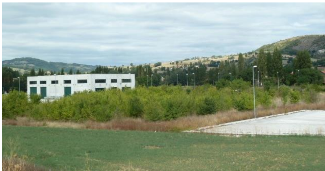
FIGURA 4-11 RIPRESA FOTOGRAFICA DA TERRA DELL'AREA DI CANTIERE "CB"
