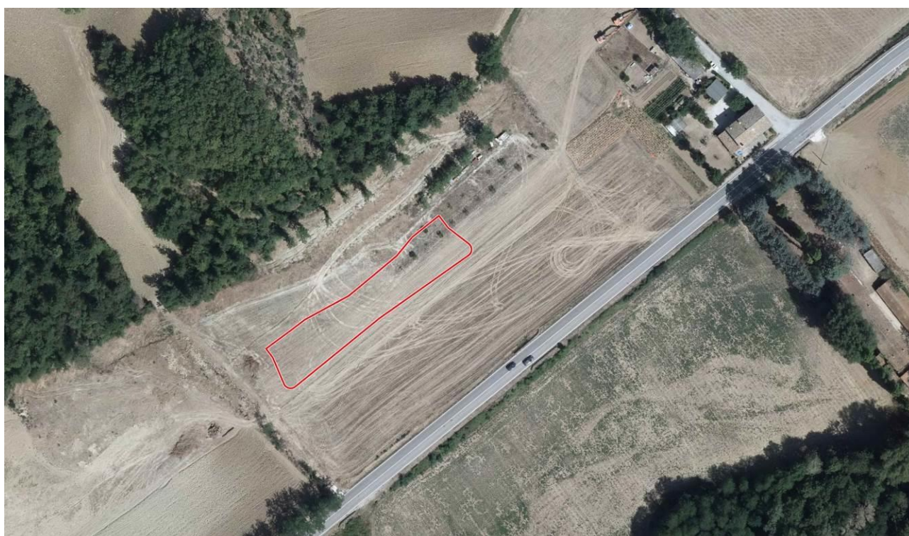
FIGURA 4-23 FOTOPIANO CON INDIVIDUAZIONE DEL CANTIERE "C"
