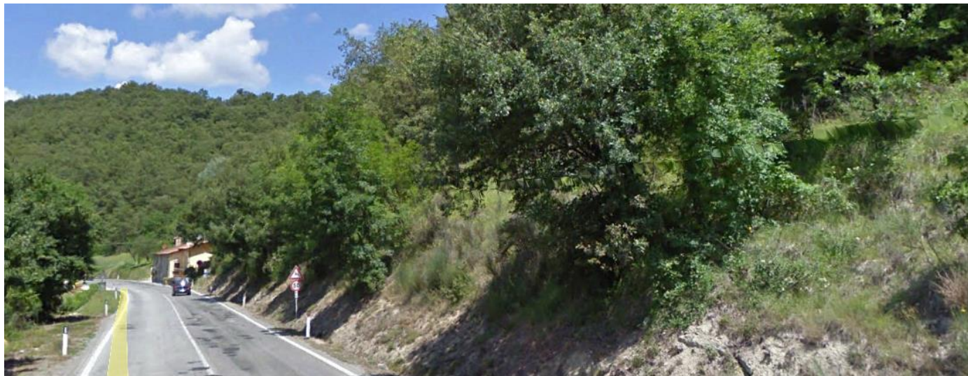
FIGURA 2-9 – VERSANTE BOSCATO TRA LA GALLERIA PIETRALUNGA 2 E LA GALLERIA MOLINELLO
