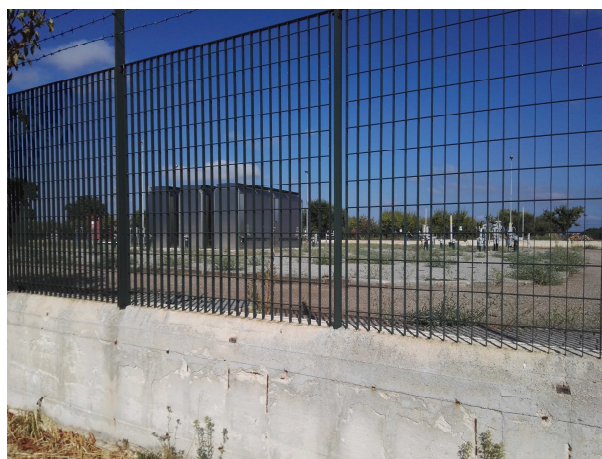
Foto 3: Vista Lato NORD impianto SNAM esistente.
