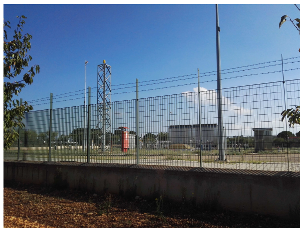
Foto 5: Vista Lato EST impianto SNAM esistente.
