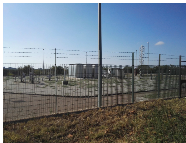
Foto 4: Vista Lato SUD impianto SNAM esistente.
