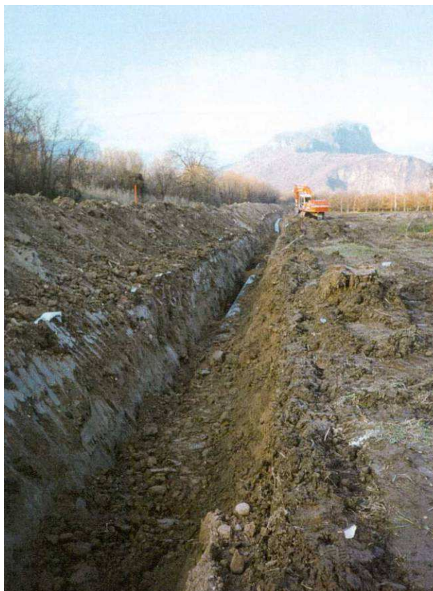
Fig. 2.3 - Operazione di rinterro della condotta.
