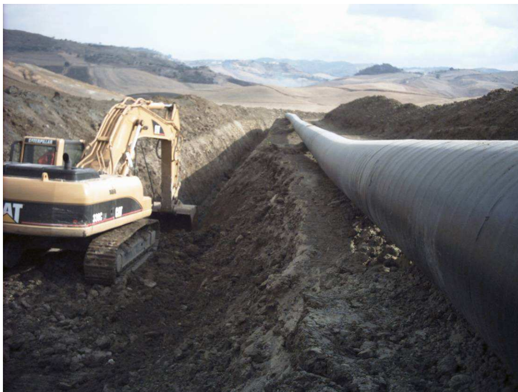
Fig. 2.2 - Scavo per l'alloggiamento della condotta.
