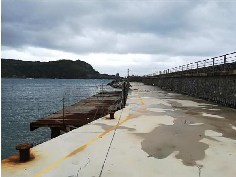
Figura n. 8 - Vista area sopraflutto interdotta
