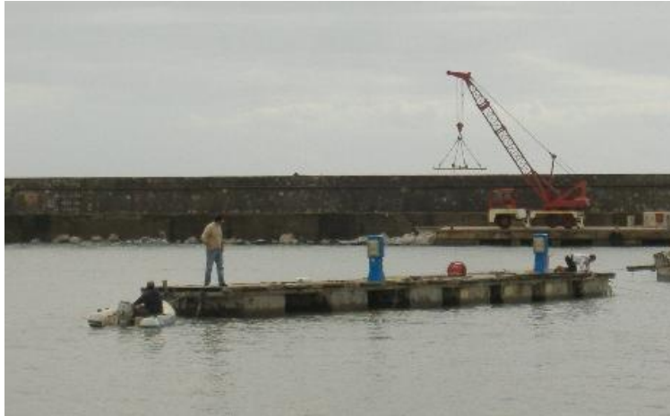
Figura n. 7 - Vista interventi di recupero pontili sottoflutto e interventi sulla mantellata sopraflutto
