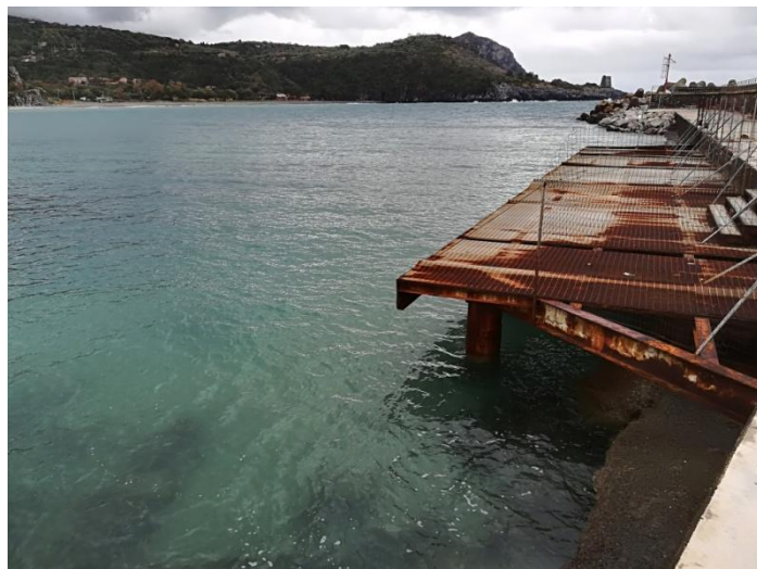
Figura n.10 - Vista area sopraflutto interdotta
