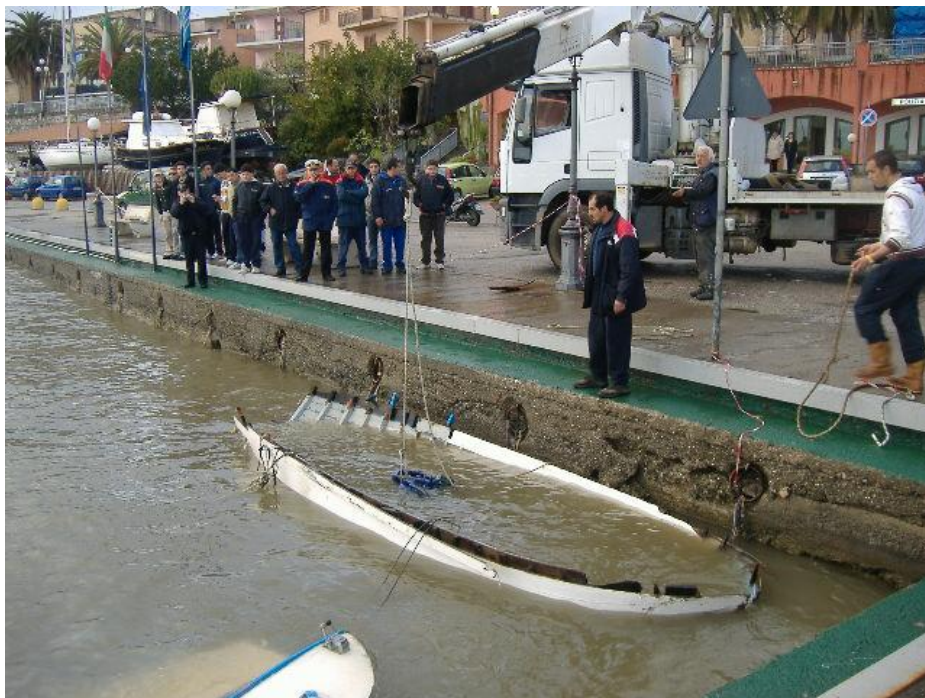
Figura n. 4 - Vista dei danneggiamenti in corrispondenza del sottoflutto e recupero delle imbarcazioni
