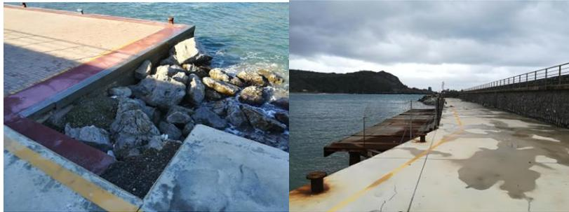
Figura n. 16 - Vista dei degradi del sopraflutto e della tracimazione e zona interdetta
