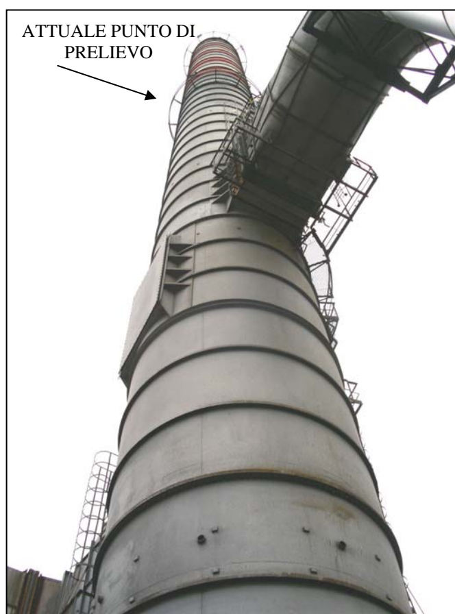
Camino dell’Impianto di Cogenerazione
