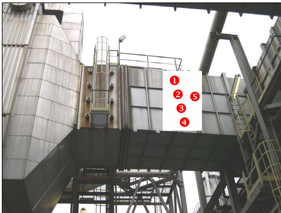
Schema prese prelievo nel tratto B del condotto B01
