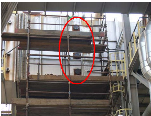
Prese per attività di profilatura per polveri e portata fumi (1, 2, 3 e 4)
