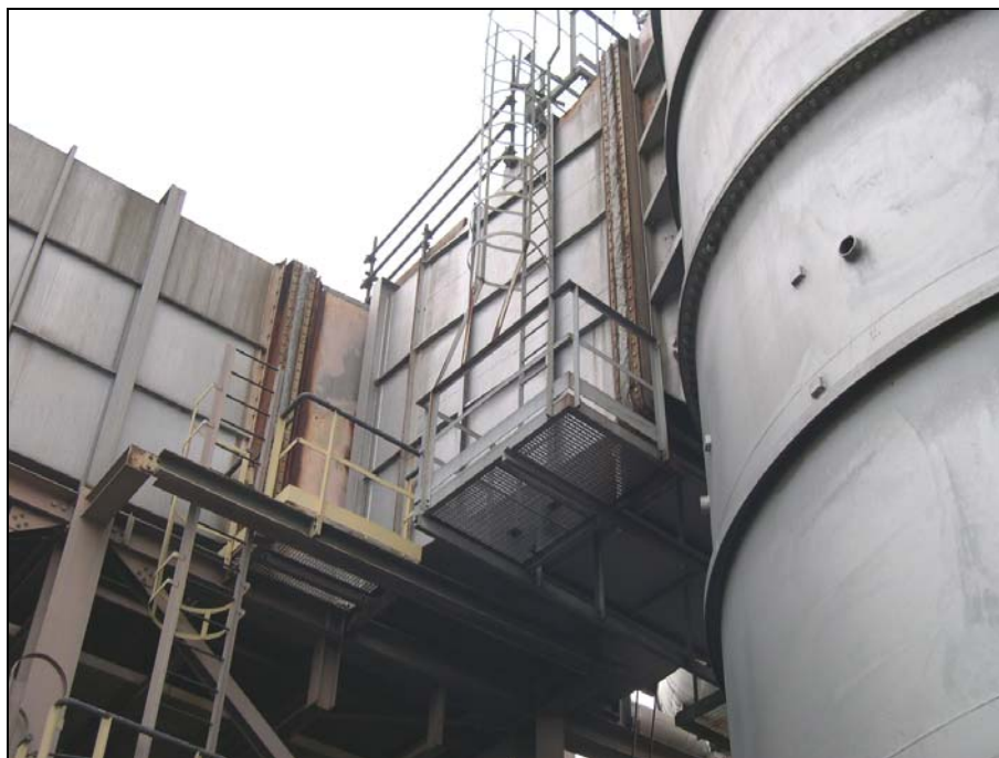
Tratto A del condotto B01
