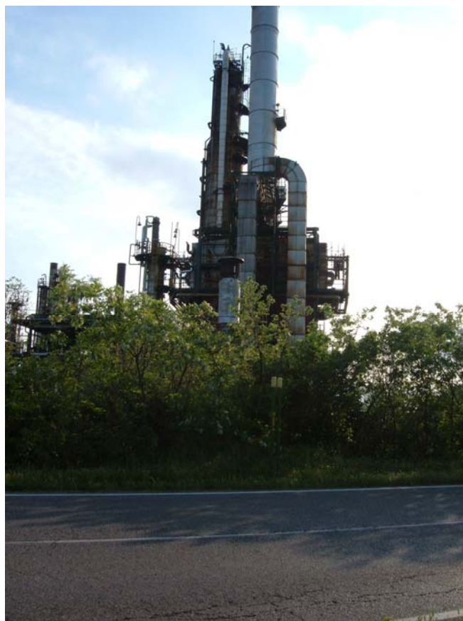
Figura 3.3: Impianti IES e strada di traffico adiacente al Recettore R4
