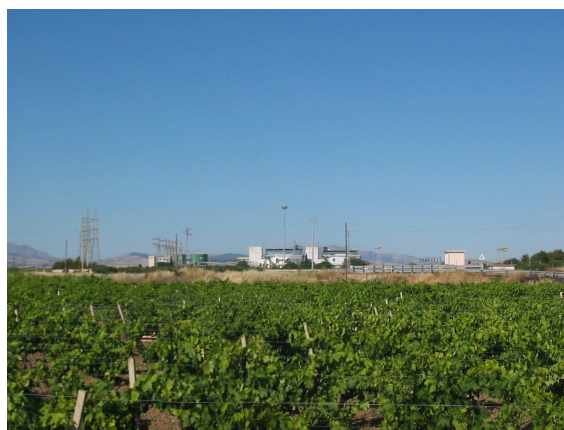
Punto A3: vista dell'impianto
