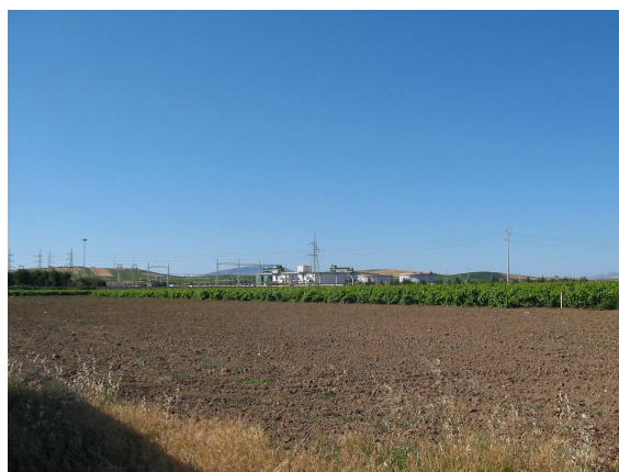
Punto A4: vista dell'impianto
