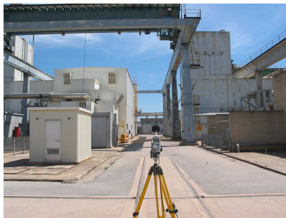
Punto I2: dell'edificio turbina GR 1 e del camino GR2
