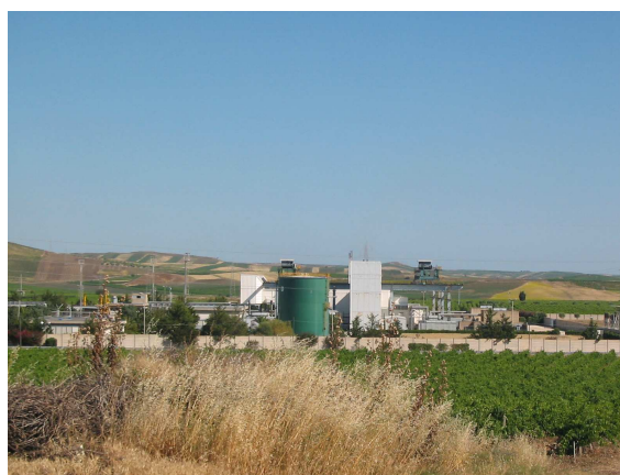
Punto A2: vista dell'impianto
