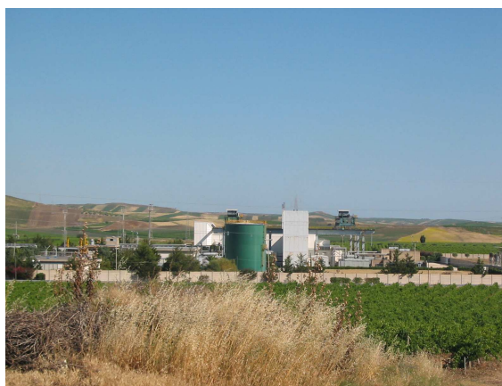
Punto A2: vista dell'impianto
