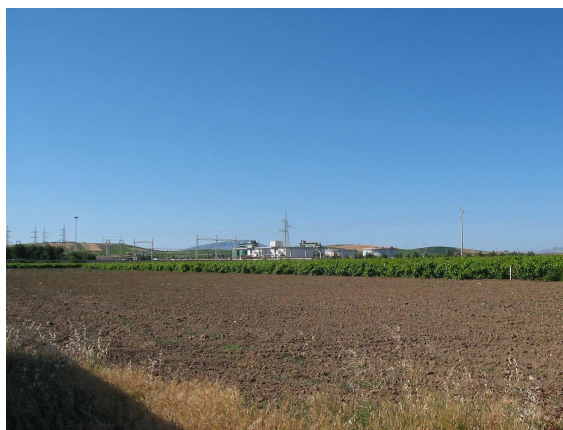
Punto A4: vista dell'impianto
