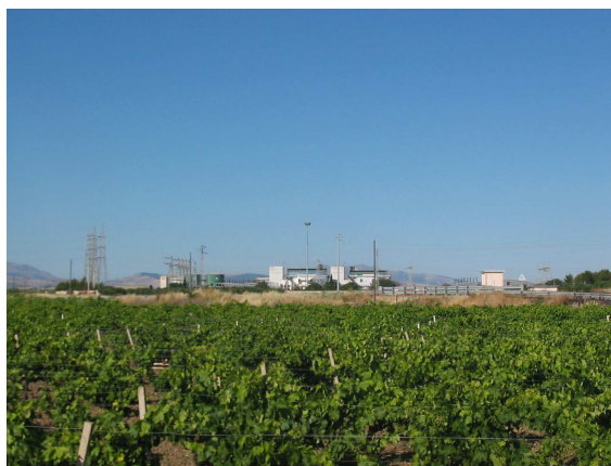
Punto A3: vista dell'impianto
