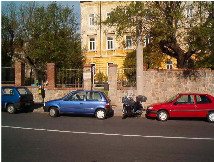
Fig. 21 – Via dell'Istria – Scuola dell'infanzia – vista esterna
