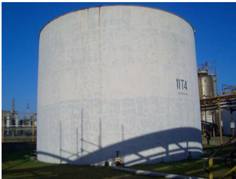
3 – Serbatoio di stoccaggio acque trattate
