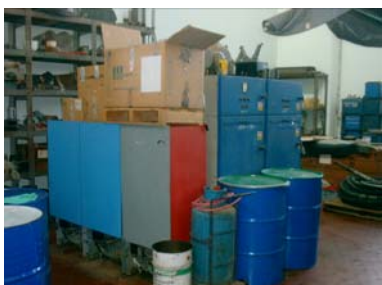
Torre di smontaggio SSI 150 KV
