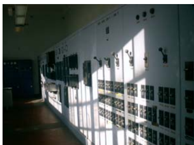
SSI10kV servizi sala controllo piano terra: nr 1 interruttore SACE sospetto
