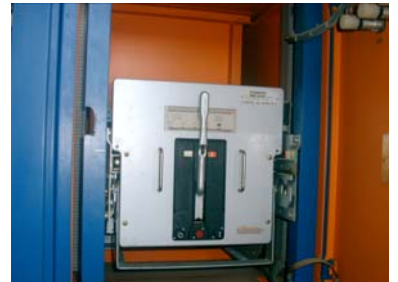
cabina 36 quadro BT tipo PC presenti 3 interruttori serie CONTROL tipo B costruttore MARINI GALILEO con sospetta presenza garza in amianto
