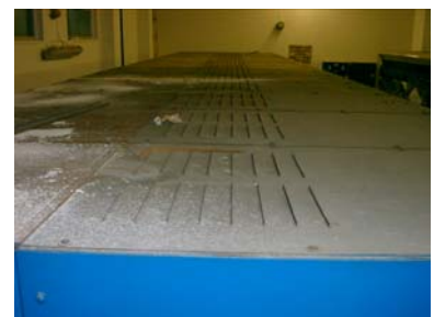
cabina 6kV-CT2 sopra quadro MT
