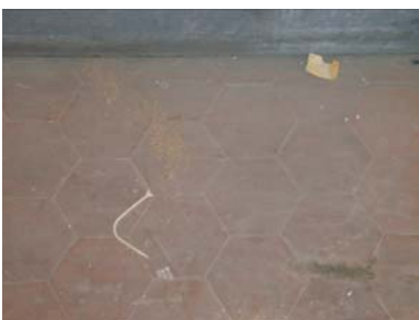
cabina 10kVSSIII sala quadri
