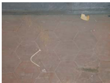
cabina 10kVSSIII sala quadri
