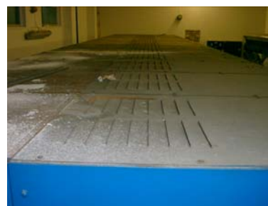
cabina 6kV-CT2 sopra quadro MT
