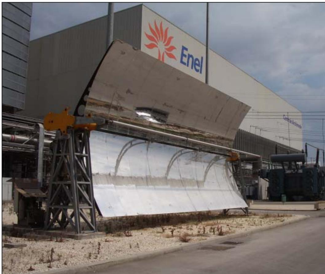
**Figura 5.2.2-1 – Modulo pilota del concentratore parabolico solare presso la Centrale a ciclo combinato Archimede di Priolo Gargallo (SR)**
