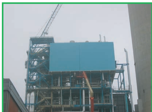
Montaggio della cabina silente sui corpi cilindrici sul piano servizi del GVR del nuovo Gruppo 6
