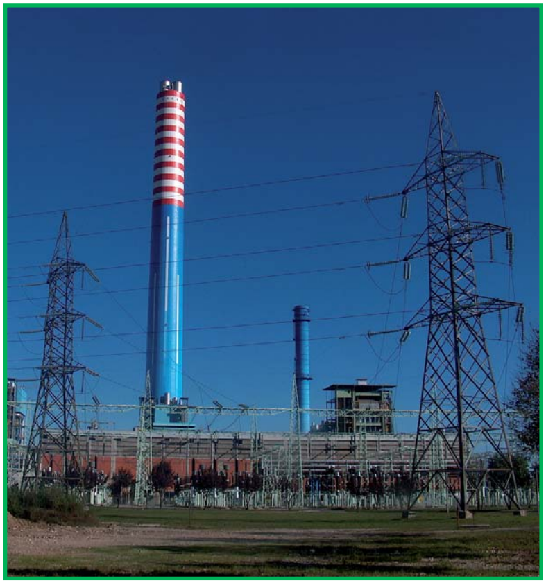
Il camino da 200 metri al termine della tinteggiatura
