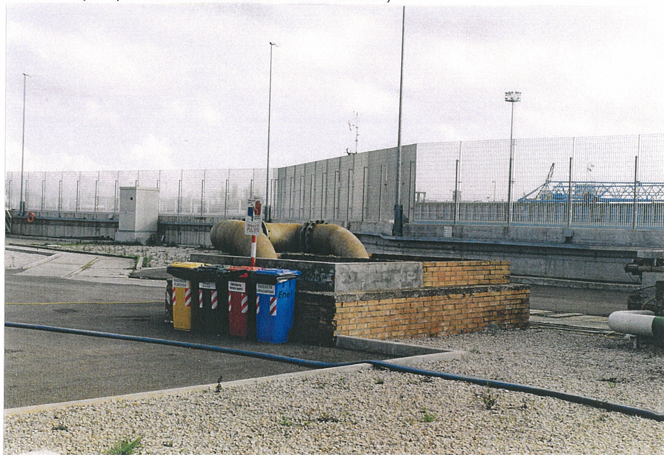
P8 – scarico (asse pozzetto in muratura riferito al limite banchina)
