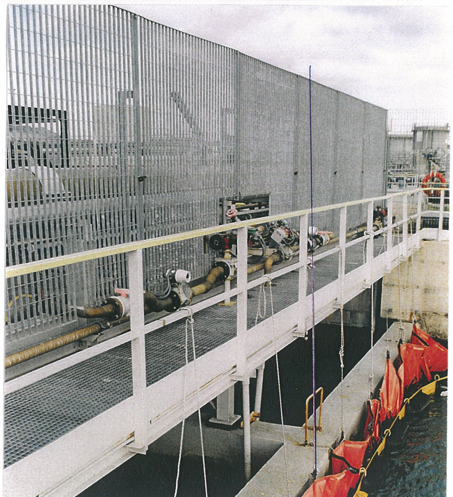
Opera di presa 1-2 (punto centrale)
